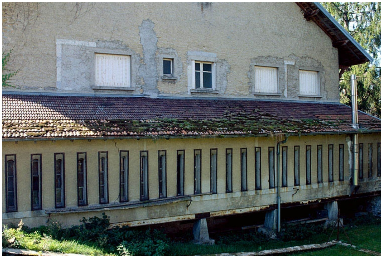
Ancienne chambre à lait en façade postérieure.
