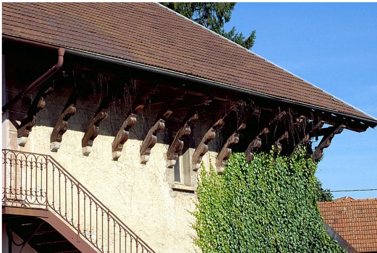
Aisseliers sculptés sur la façade orientale.
