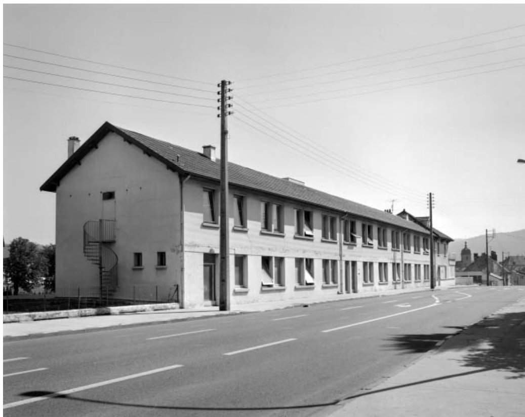
Atelier de fabrication depuis le nord-ouest.
