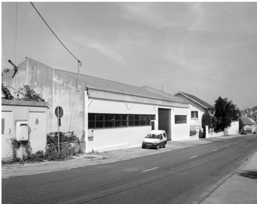
Atelier de fabrication rue Paul Cretin. 39, Champagnole les Moutoux
