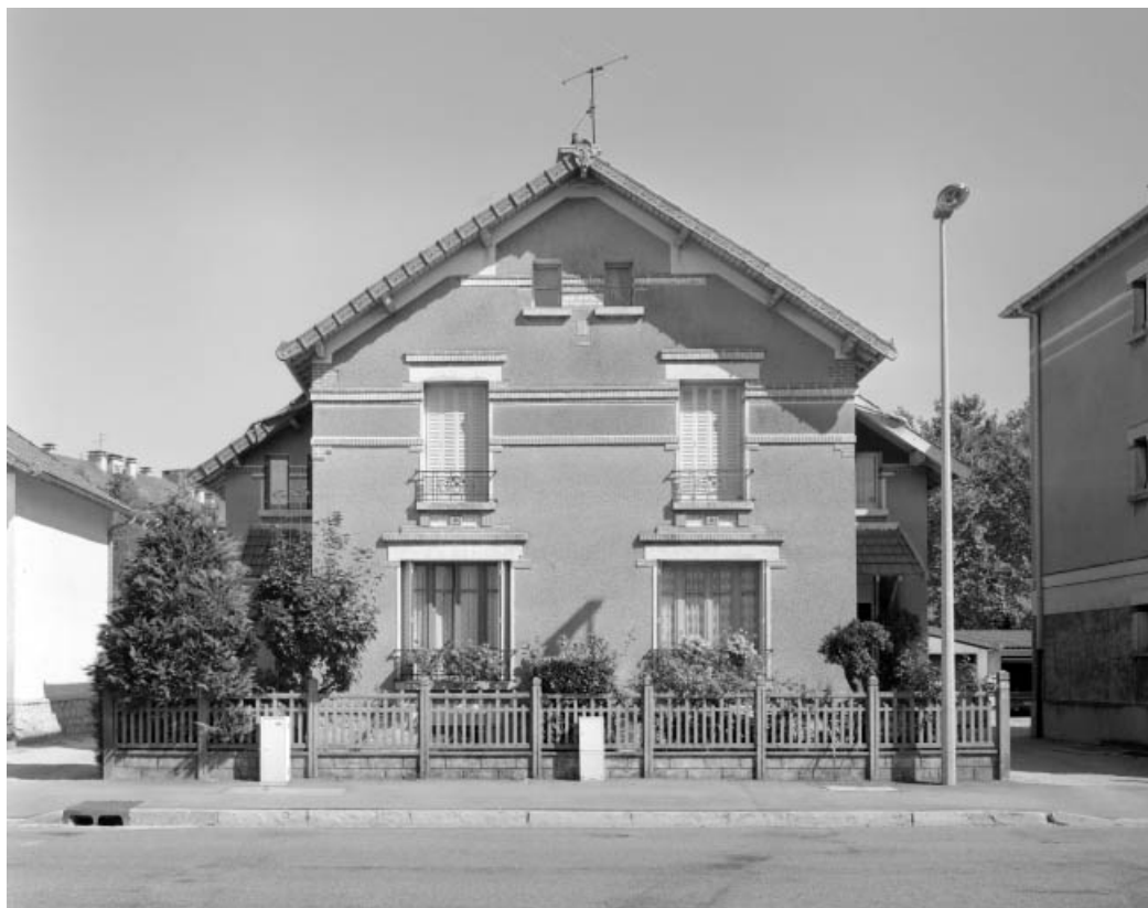
Façade antérieure d'un logement double (cadrage horizontal).
