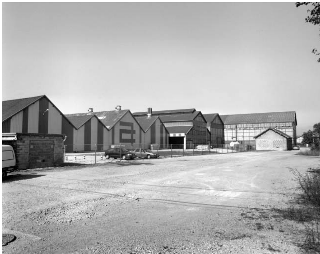
Façades postérieures des ateliers de l'ancienne forge.
