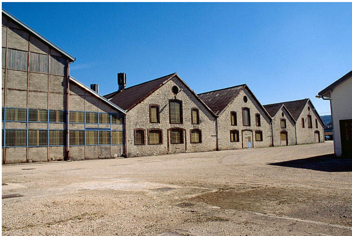
Façade des ateliers de l'ancienne forge depuis la cour.
