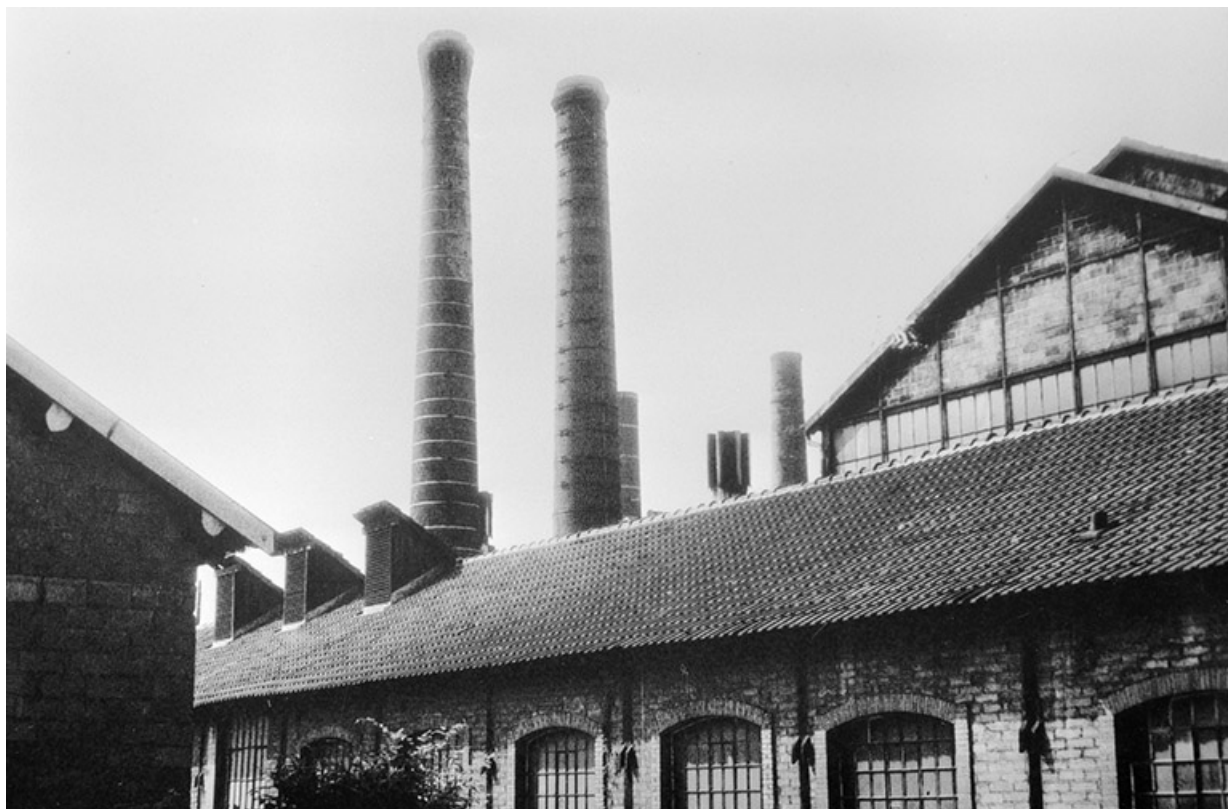
Façade postérieure du bâtiment des compresseurs.
