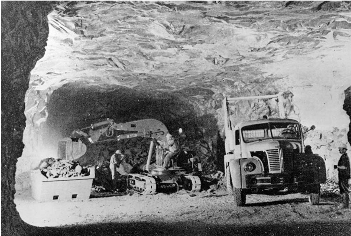
Chargement et évacuation du calcaire.
