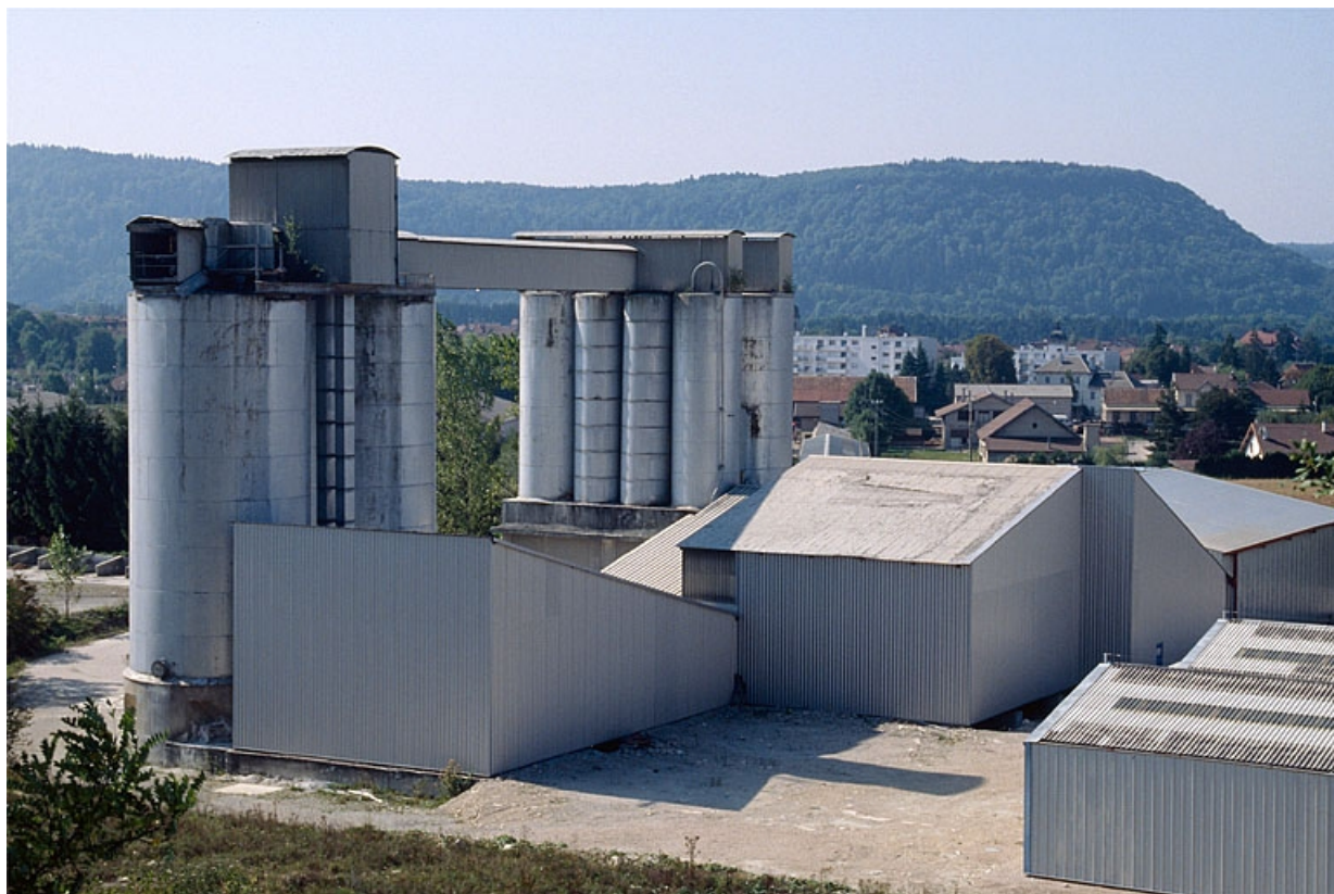
Vue plongeante sur le magasin industriel et l'atelier de conditionnement.
