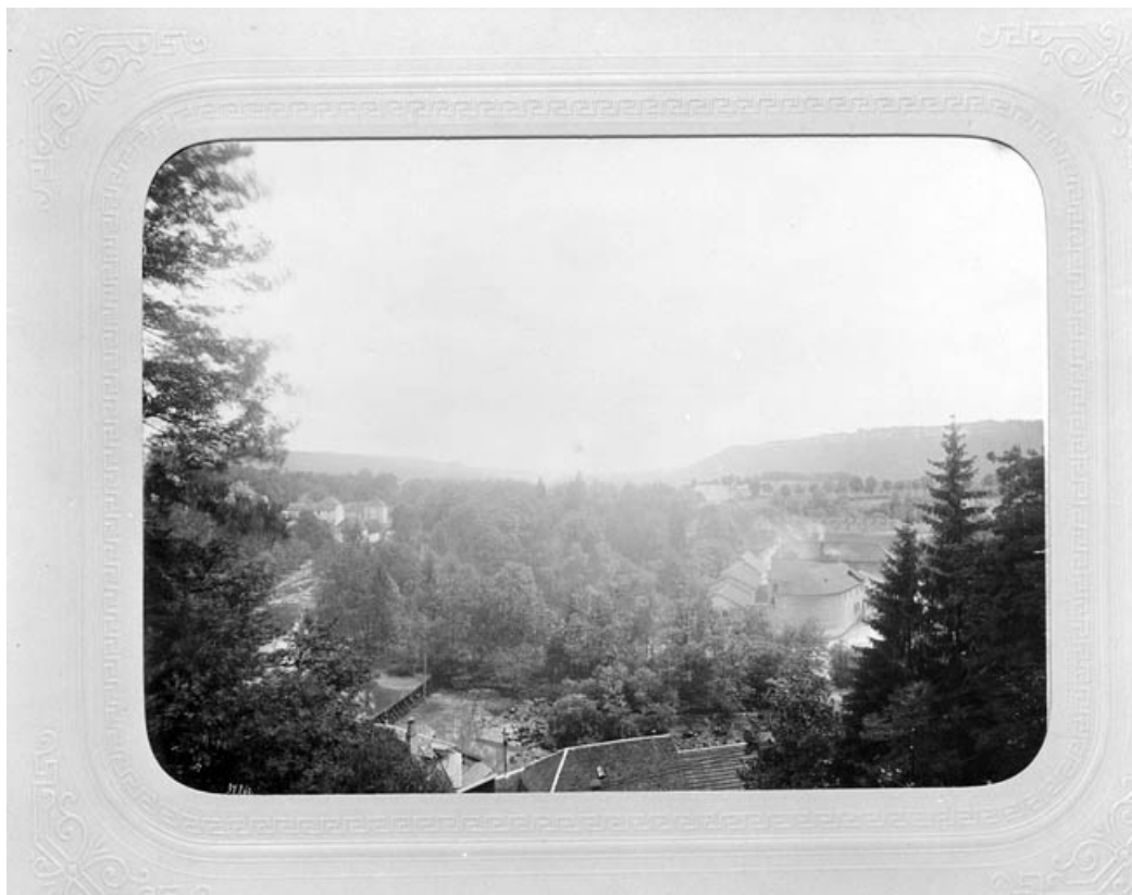
Vue d'ensemble depuis le nord, à la fin du 19e siècle.
