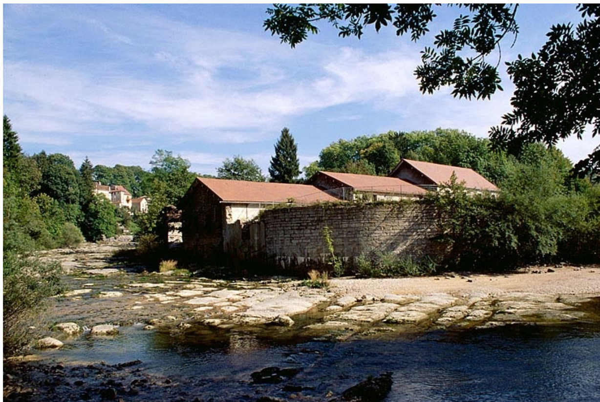
Extrémité nord depuis la rive droite.
