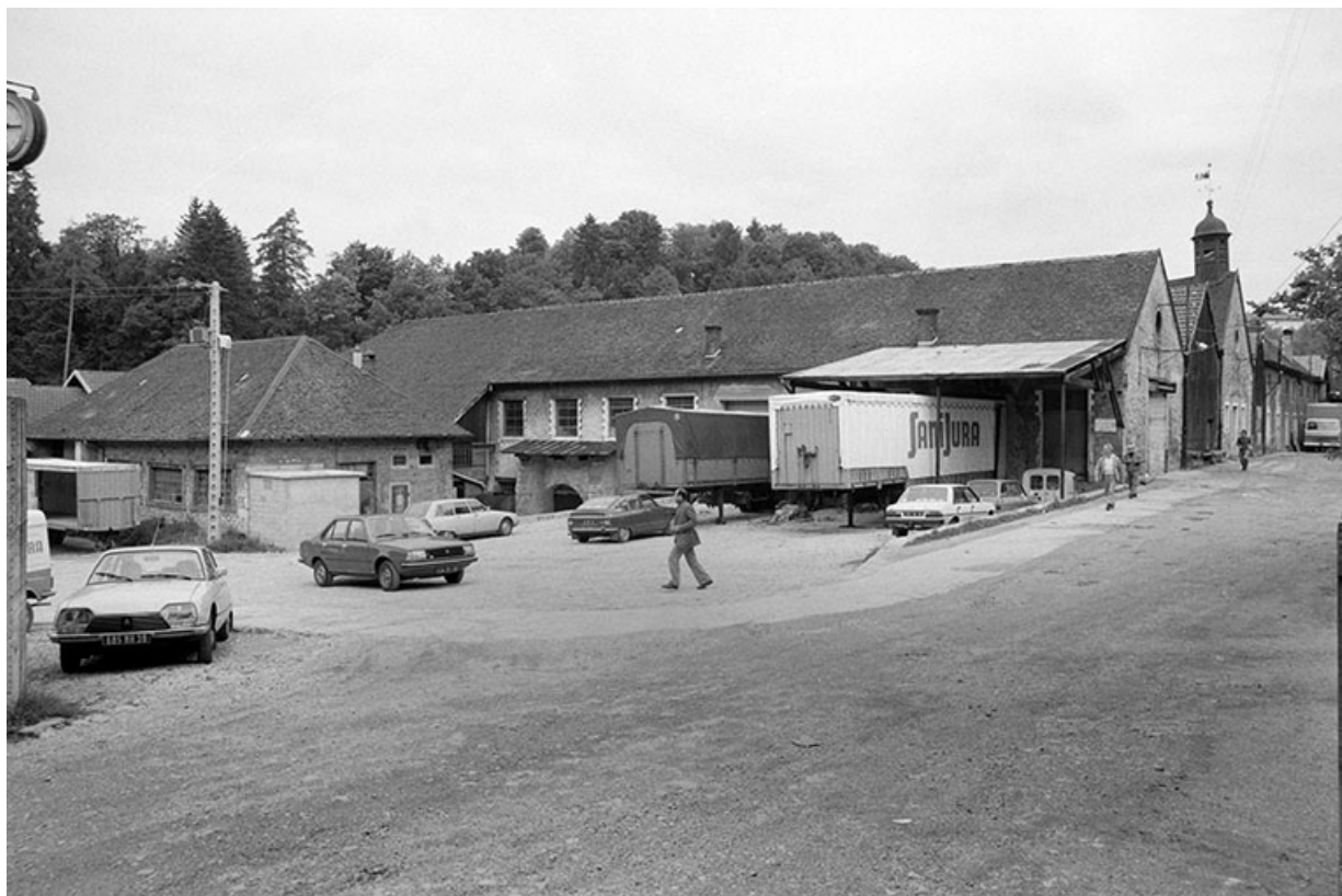
Vue d'ensemble depuis l'entrée en 1980.
