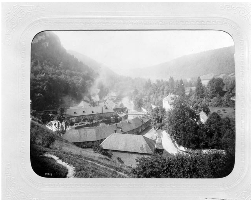
Vue d'ensemble de l'usine, à la fin du 19e siècle.
