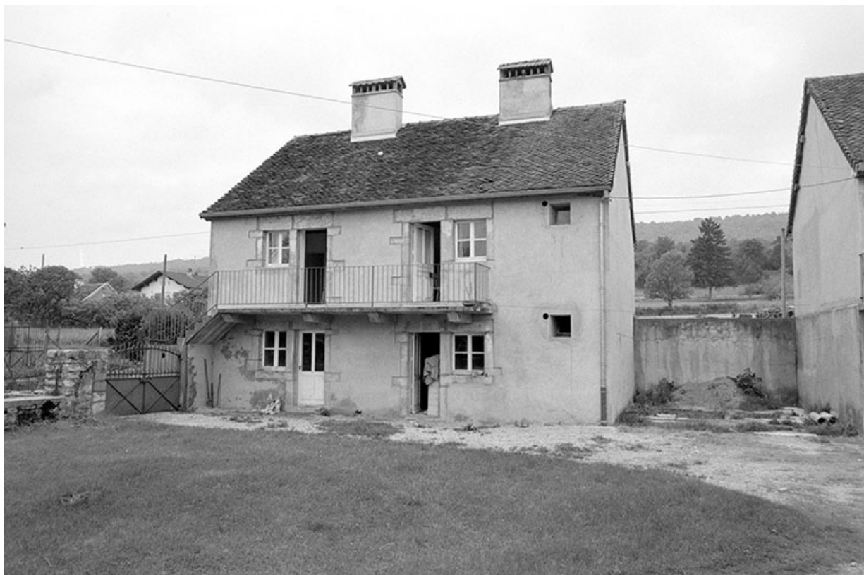
Façade sur cour d'un logement ouvrier.
