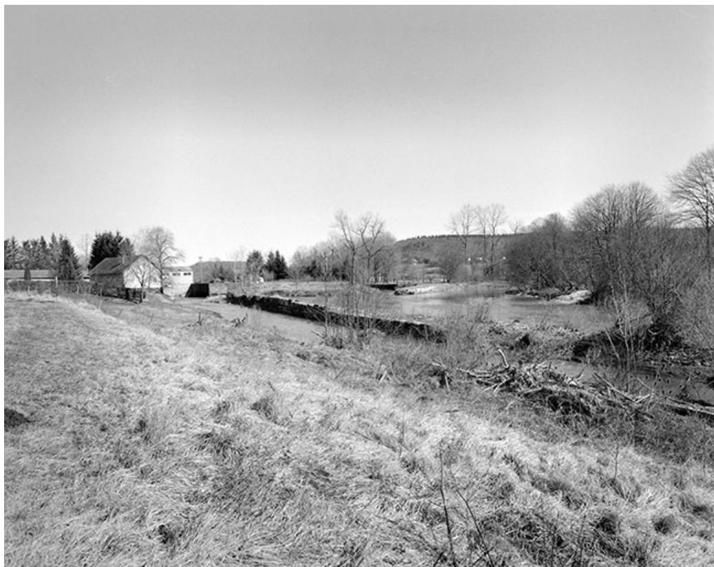
Le canal de fuite et l'Ain depuis le sud-ouest.
