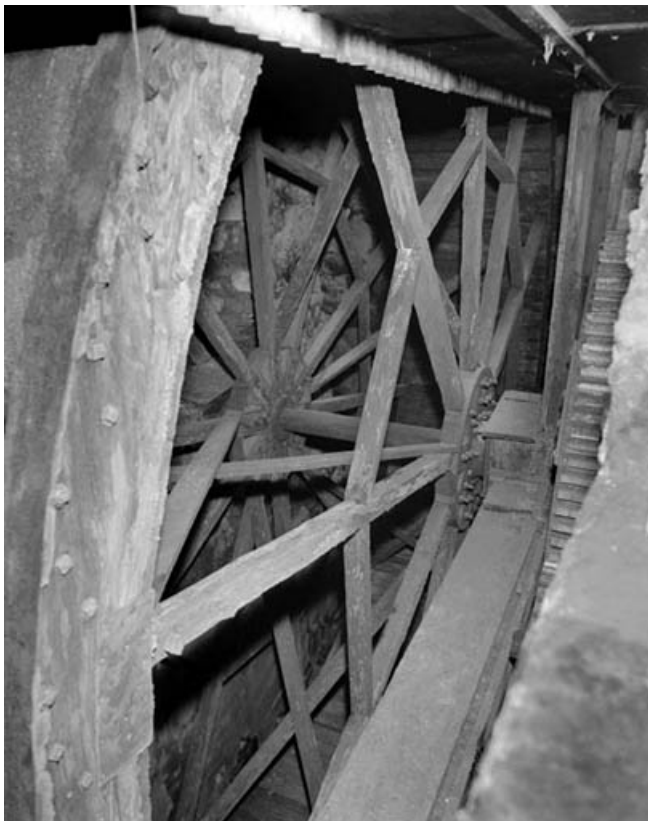
Détail de la charpente de la roue hydraulique.
