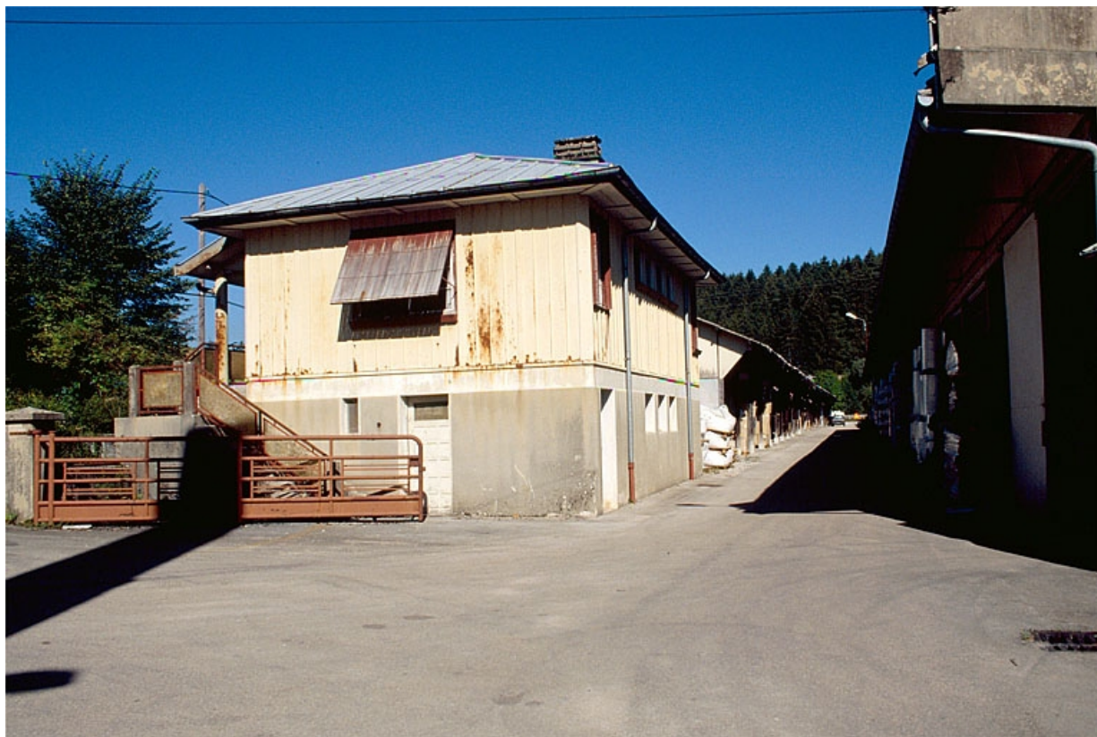
Conciergerie (maison métallique Fillod). 39, Ardon R.D. 27
