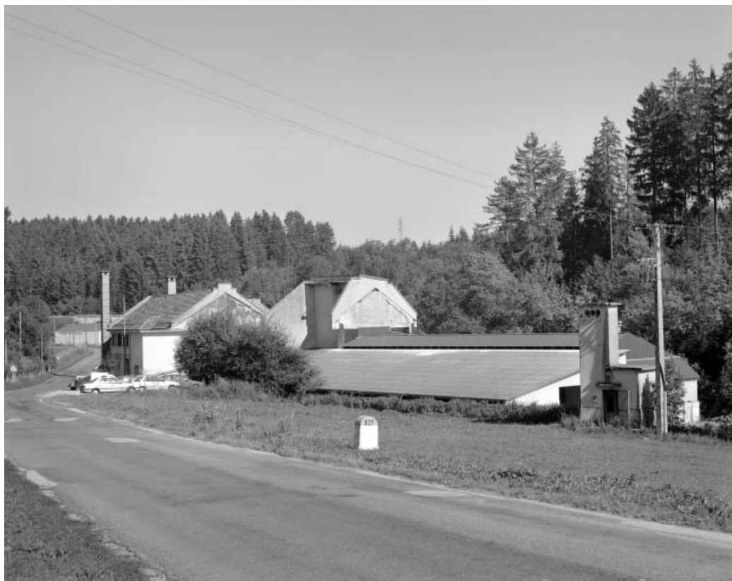
Vue d'ensemble depuis l'ouest.
