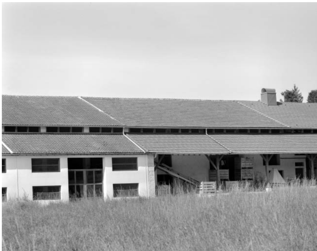
Séchoir : détail de la façade antérieure.
