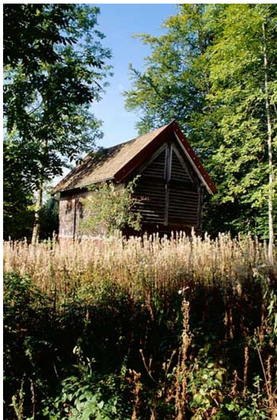
Vue de trois quarts du hangar séchoir.
