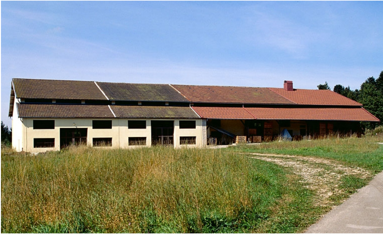
Façade antérieure du séchoir (ancienne ferme de Montrainçon). 39, Supt, lieudit : la Joux
