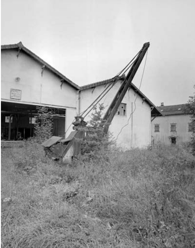
Grue sur l'aire des matières premières. 39, Andelot-en-Montagne, lieudit : la Gare
