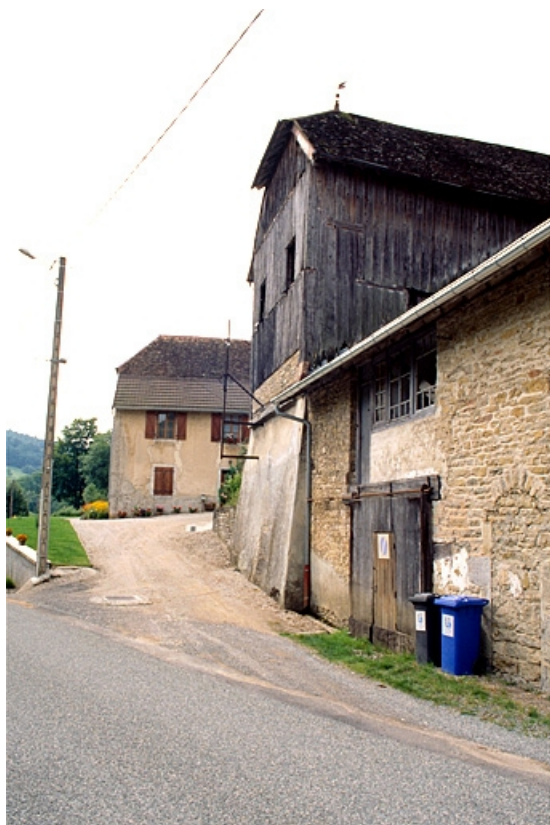
Élévation ouest de l'atelier de fabrication. La partie talutée correspond au soubassement du haut fourneau. 39, Pont-d'Héry, lieudit : Moutaine
