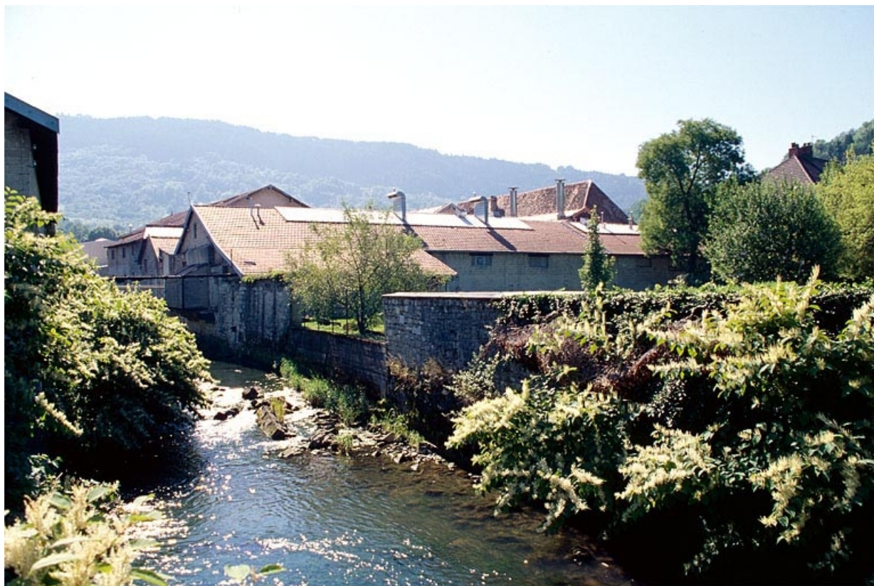
Façades postérieures depuis la Furieuse en aval.
