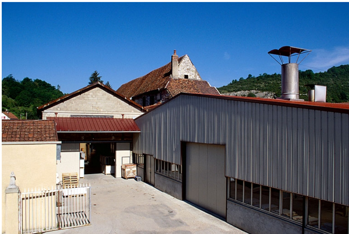
Vue sur la cour depuis les bureaux. A droite : le bâtiment du four industriel.
