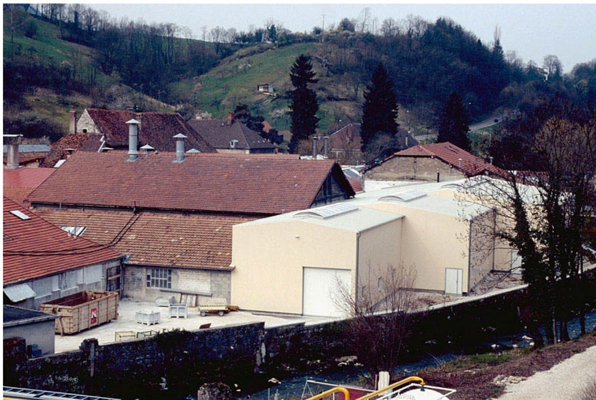
Ateliers de fabrication depuis le nord-est. Atelier de coulage à gauche et atelier de préparation des émaux à droite. 39, Salins-les-Bains, 18, 20, 22 avenue Aristide Briand
