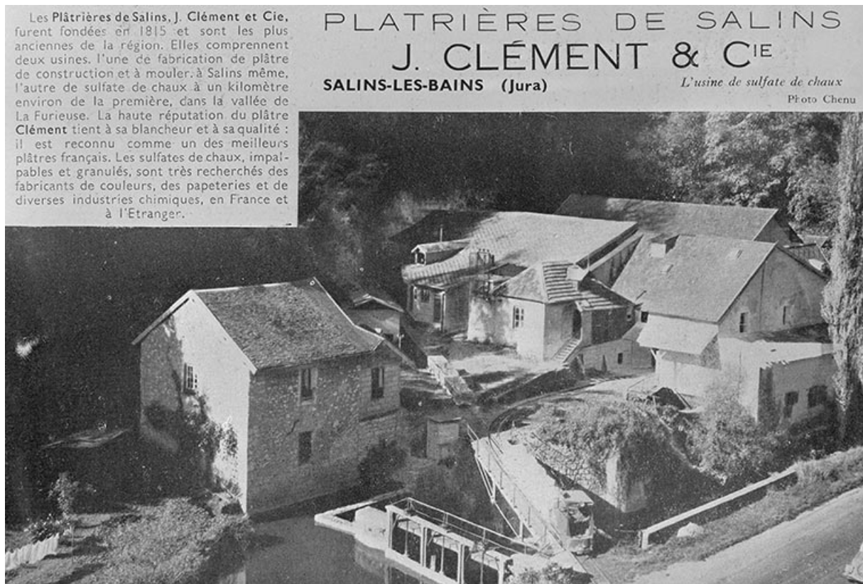
Plâtrières de Salins J. Clément & Cie. L'usine de sulfate de chaux.
