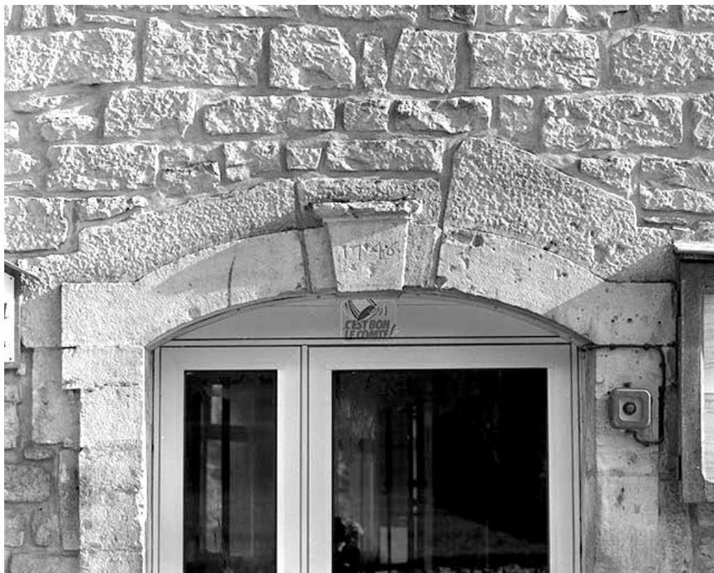
Détail de l'arc de la porte d'entrée.
