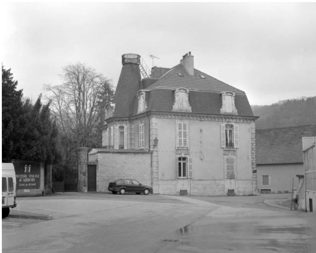
Façade latérale du château Béthanie.
