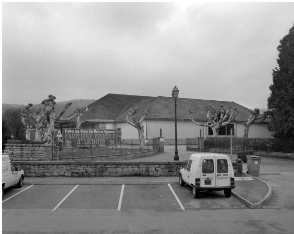
Vue d'ensemble de la nouvelle coopérative vinicole.
