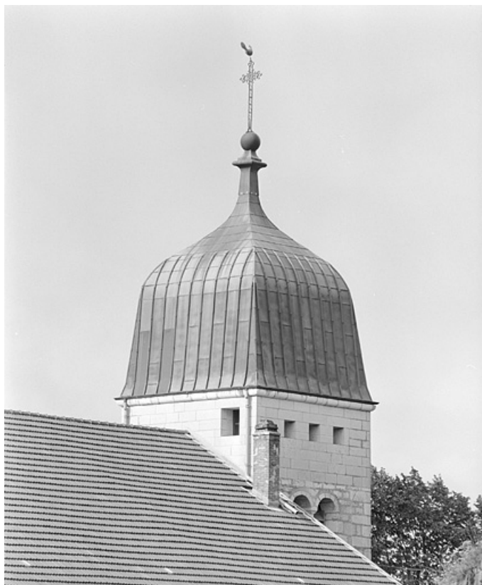
Partie supérieure de la tour-clocher.
