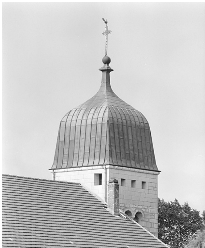
Partie supérieure de la tour-clocher.
