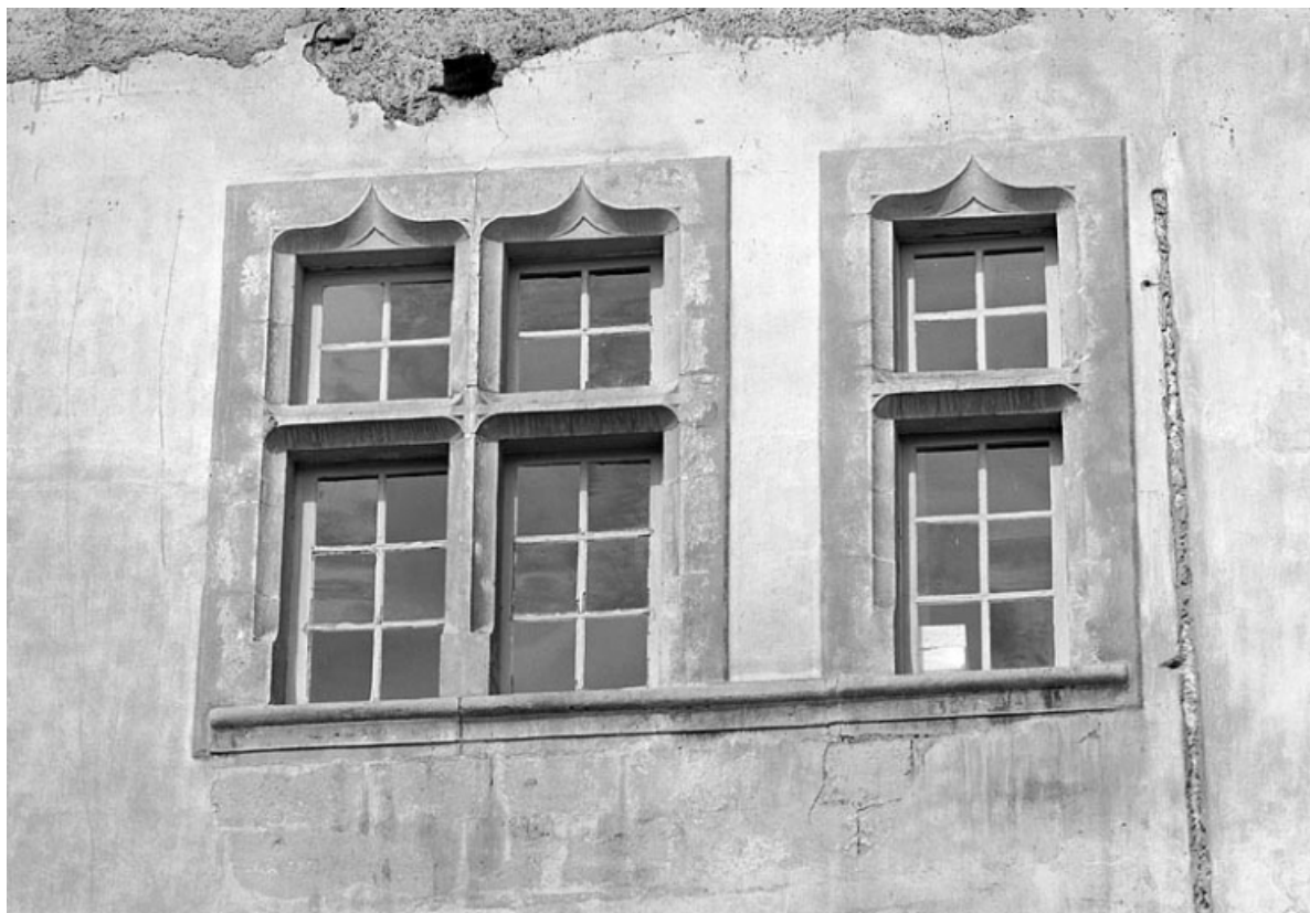
Fenêtres de l'étage de la face est.
