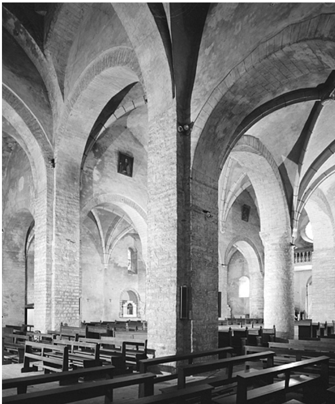
Élévation intérieure du vaisseau central de l'église vue depuis le bras nord du transept (vue verticale). 39, Saint-Lupicin
