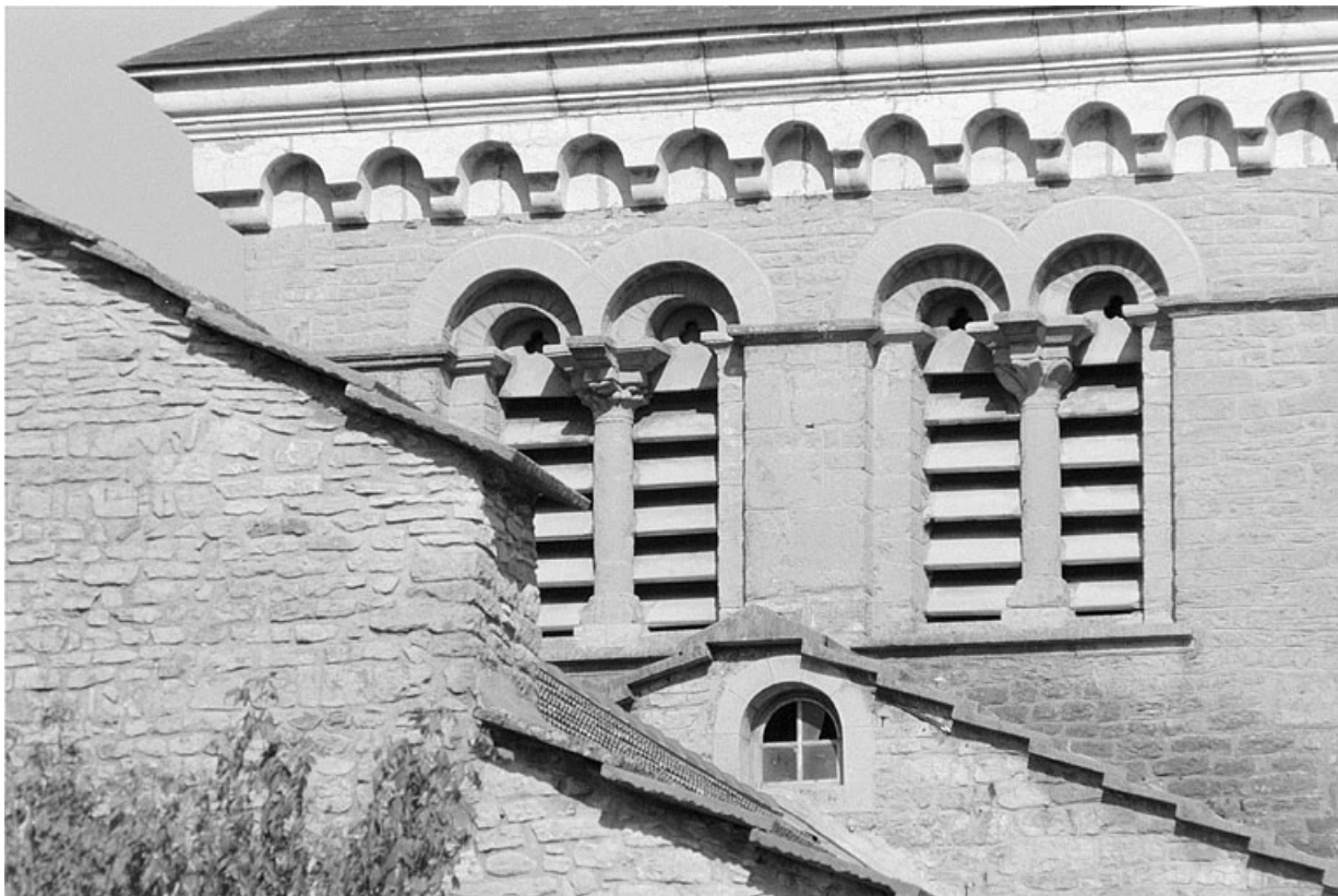
Clocher : détail des baies de la face ouest (vue horizontale). 39, Saint-Lupicin
