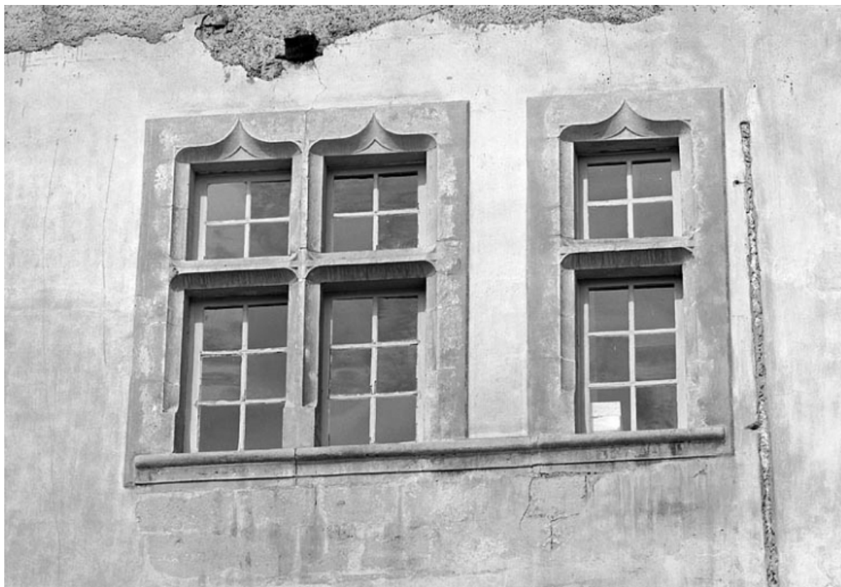
Fenêtres de l'étage de la face est.
