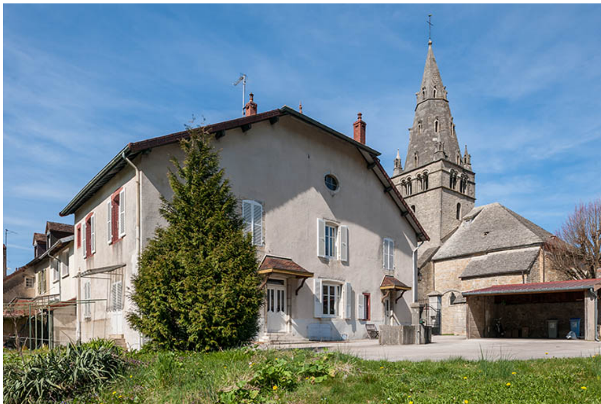
Façade est sur cour de la maison de fonction, annexe, dans son contexte, 9 place Notre Dame. 39, Poligny rue du Champ de Foire
