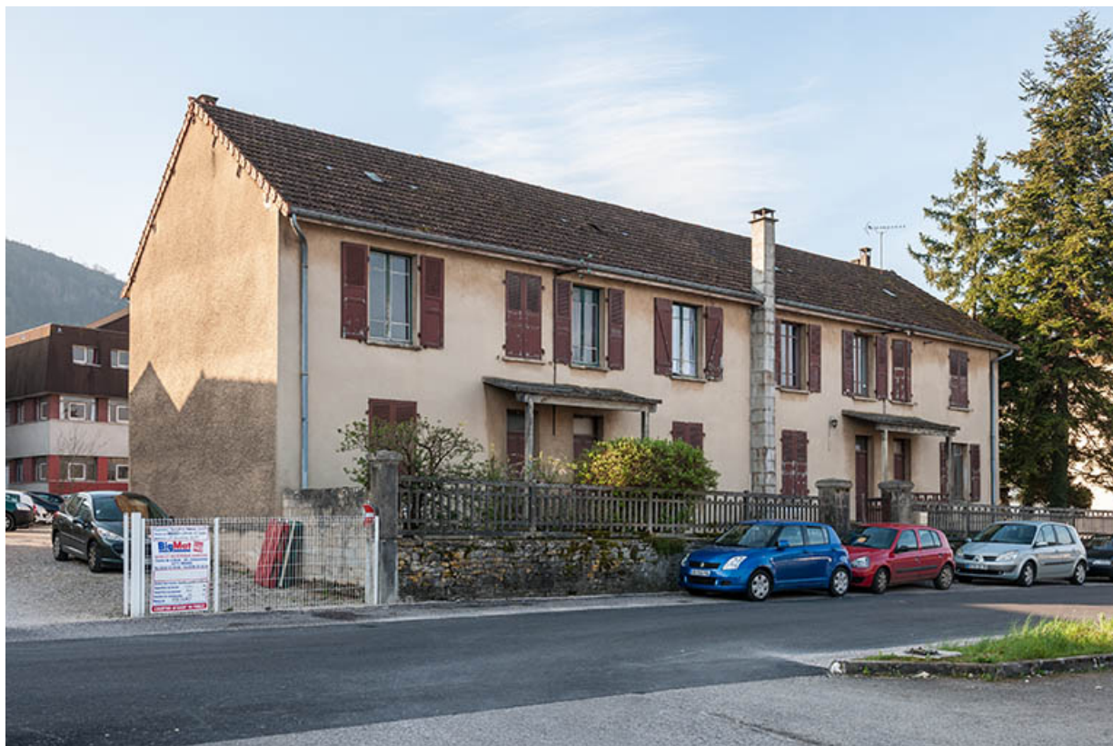
Façade antérieure nord de l'annexe (logement, atelier) sur la rue du vieil hôpital. 39, Poligny rue du Champ de Foire
