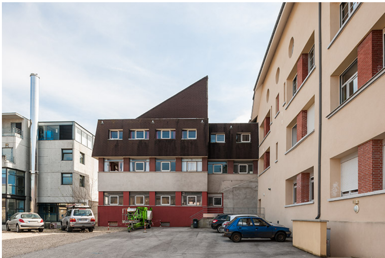
Façade postérieure est de l'école, façade nord de l'extension est de l'école et pignon nord de Cécailait. 39, Poligny rue du Champ de Foire
