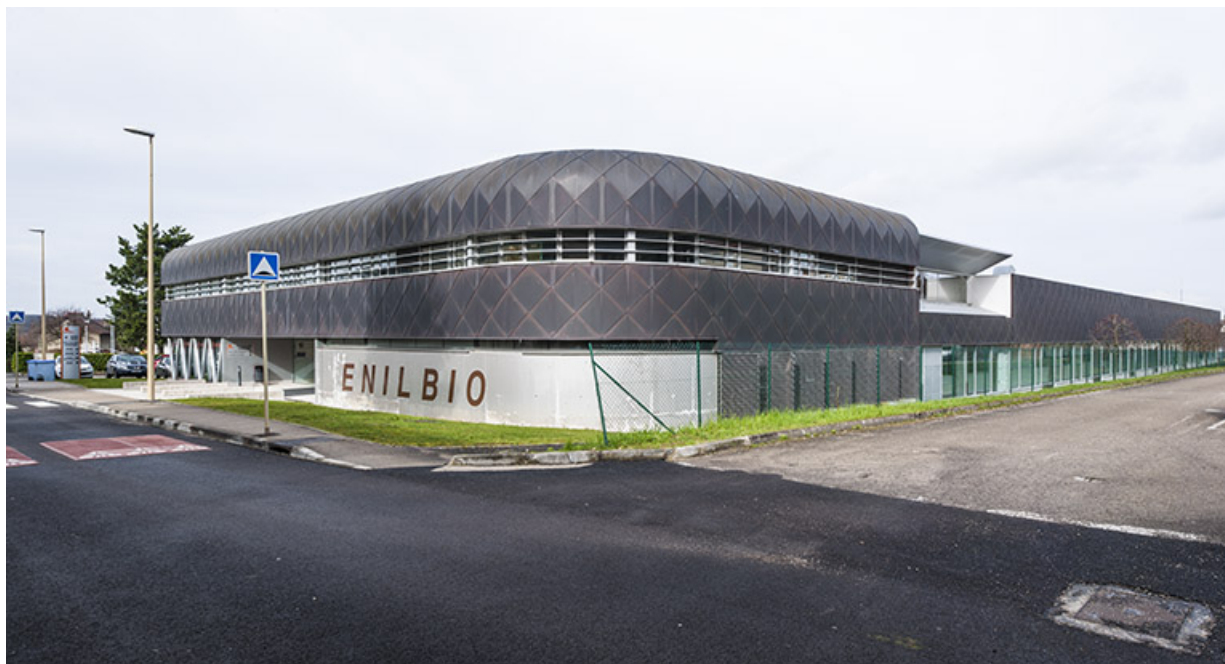
Vue sur les façades est et sud de la halle de génie alimentaire.
