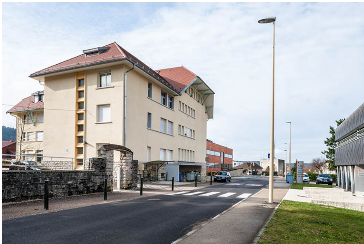
Façade nord de l'internat sur la rue du vieil hôpital.
