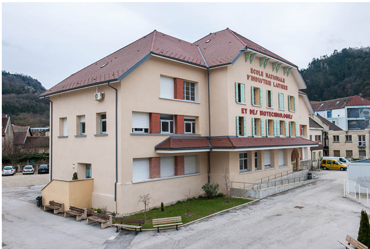
Façade antérieure principale de l'école, angle nord-ouest.
