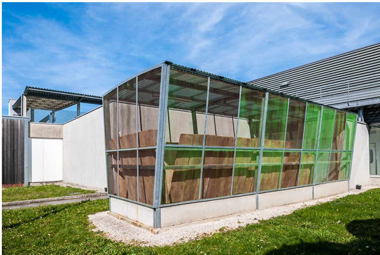
Local de séchage des planches sur la façade ouest.
