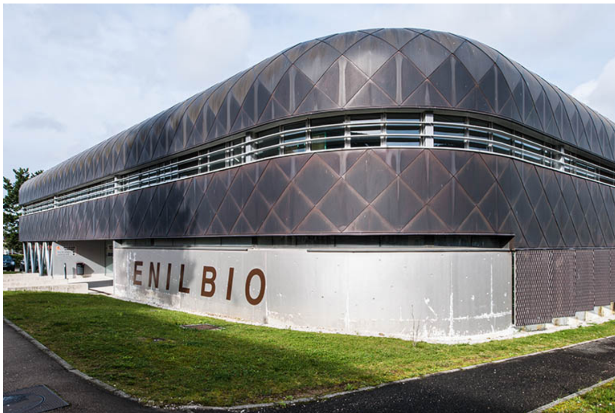
Angle sud-est et façade d'entrée sud sur rue de la halle de génie alimentaire. 39, Poligny rue du Champ de Foire
