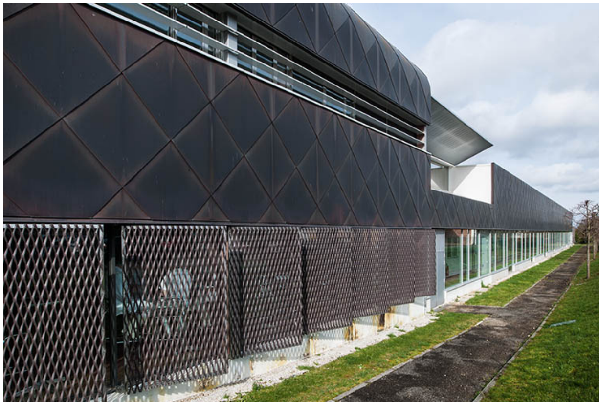
Détail de la façade orientale de la halle de génie alimentaire.
