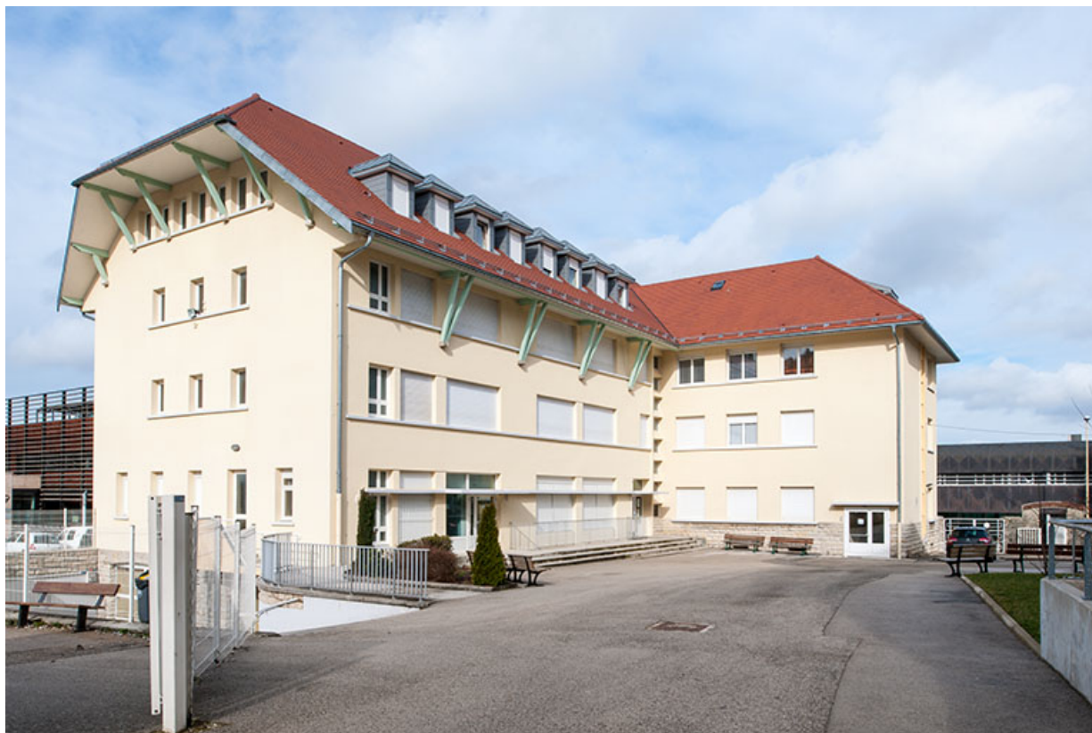
Pignon sud et façades sud et est de l'internat.
