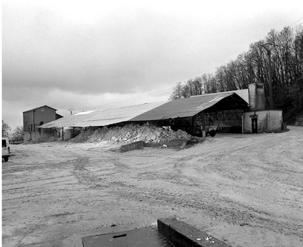
L'atelier de distribution et de concassage de la carrière.
