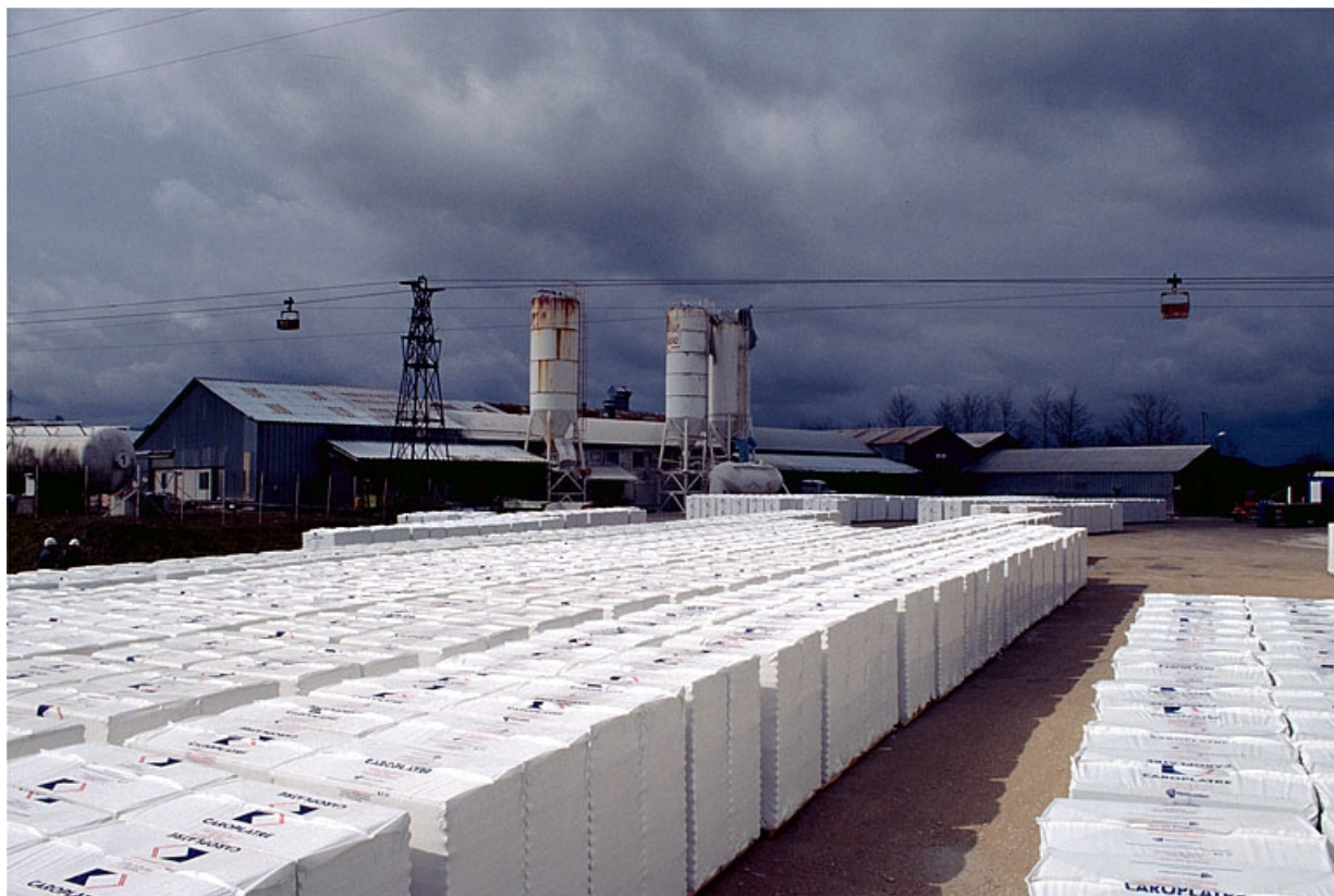
Vue d'ensemble depuis l'est (partie sud).
