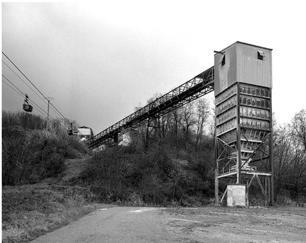
L'entrée de la carrière. Au premier plan : silo à gypse, relié par convoyeur à l'atelier de concassage. 39, Grozon, lieudit : les Plâtrières
