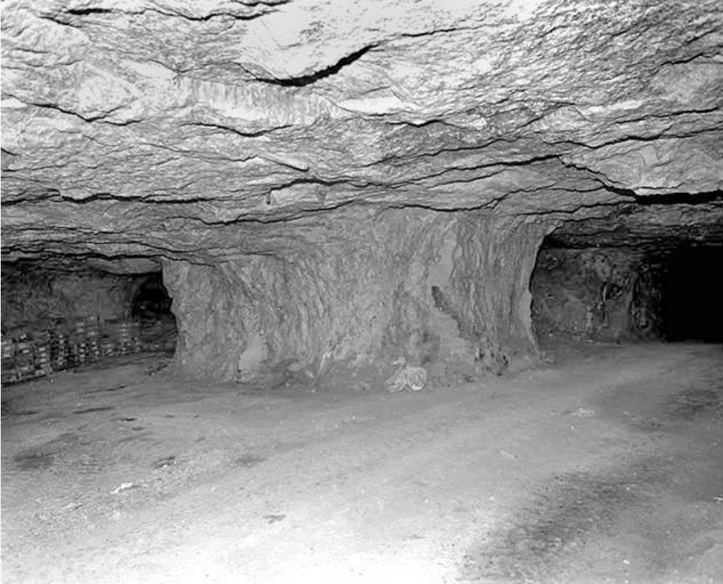
Pilier de soutènement d'une ancienne chambre d'exploitation.
