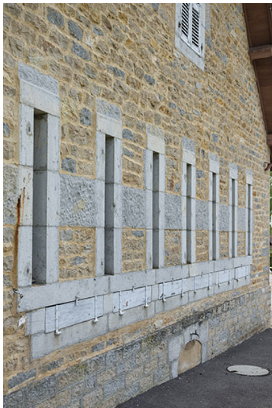
Baies de la chambre à lait et de la cave d'affinage vues de trois quarts 39, Montholier R.N. 5
