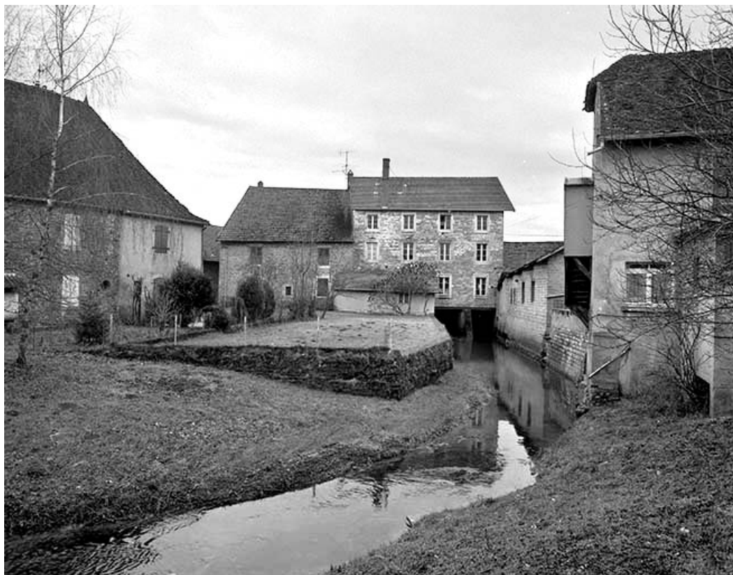
Vue d'ensemble. Façade postérieure.
