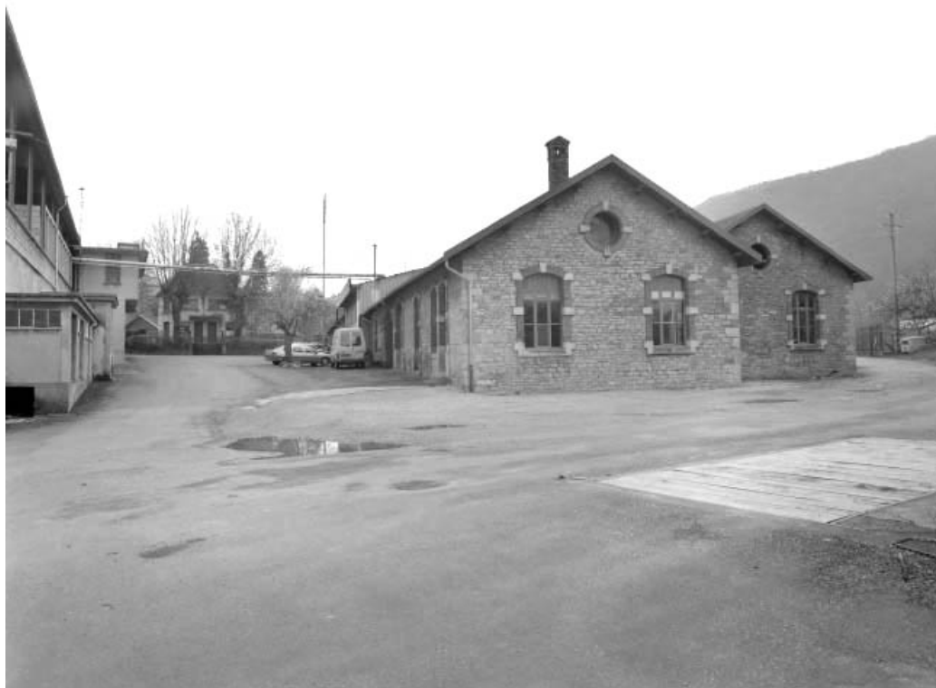
Vue des ateliers de fabrication depuis le nord.
