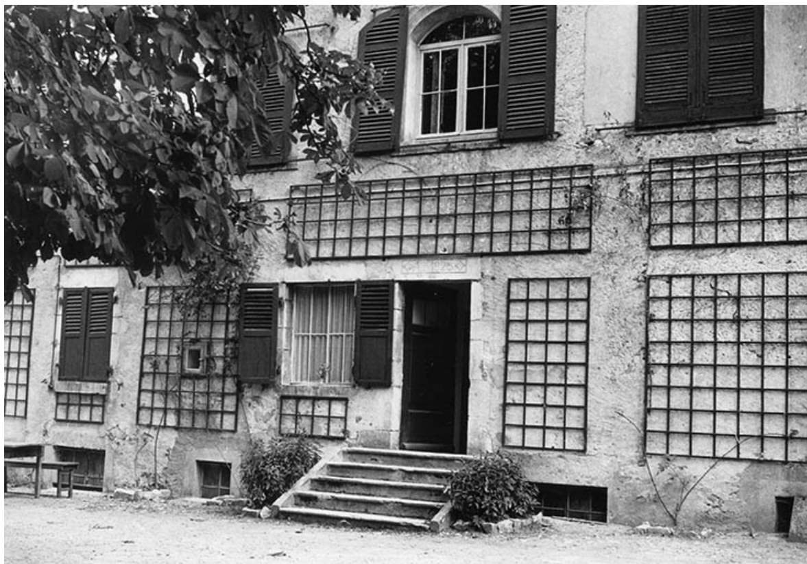
Façade ouest de l'ancien moulin à papier (?), fotogr., s.d. [début 20e siècle]. 39, Mesnay, lieudit : aux Echaillers
