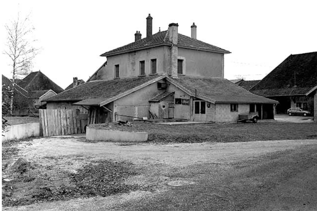
Extensions ouest et sud : pièces d'affinage et chaufferie-salle de réunion.
