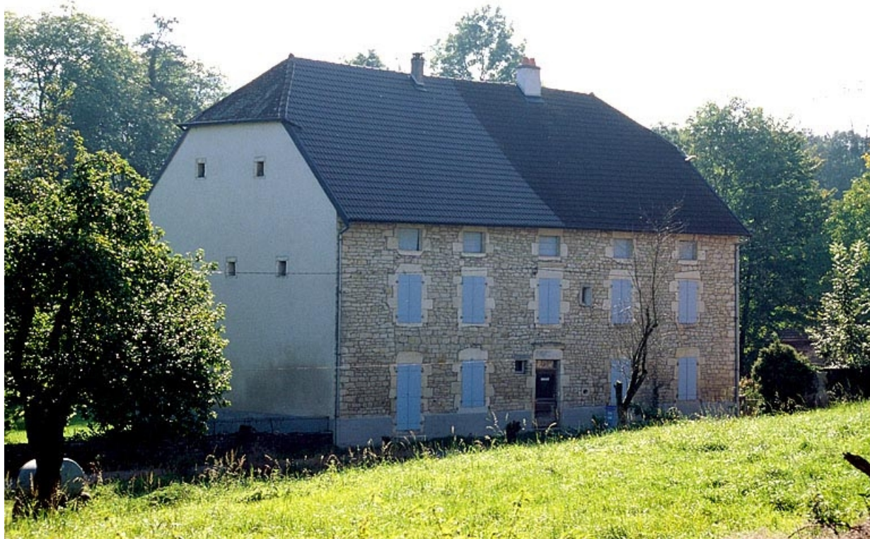
Logement patronal depuis le nord-ouest.
