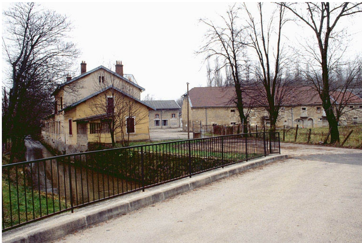
Logement, bureau et pièces d'affinage depuis le nord-ouest.
