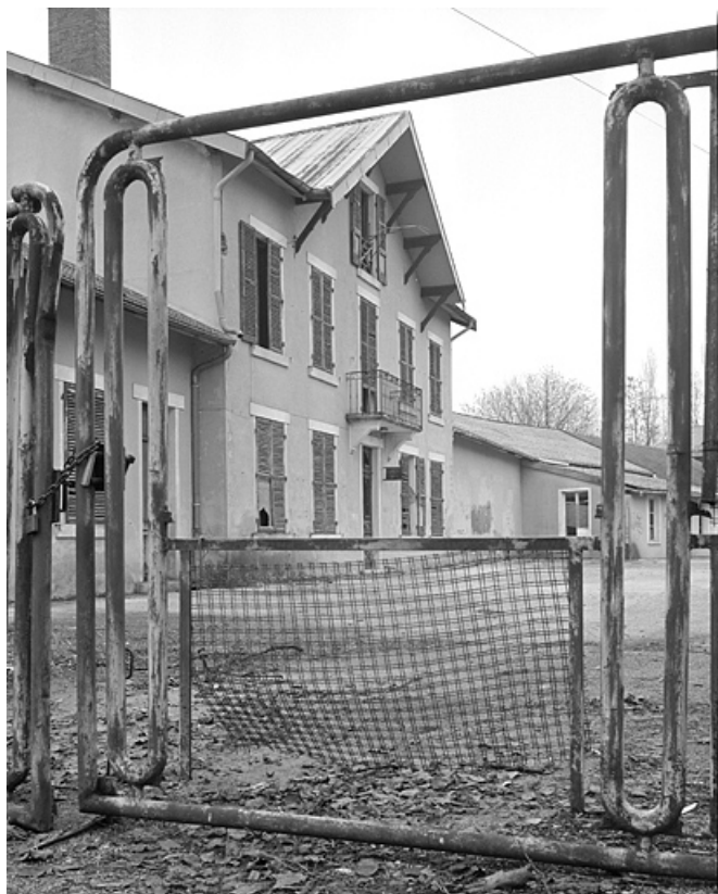
Façade du bureau et logement de trois quarts gauche.
