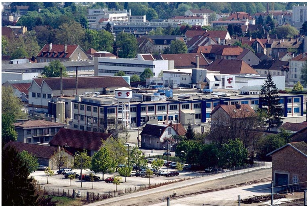
Vue d'ensemble depuis la côte de Montciel.
