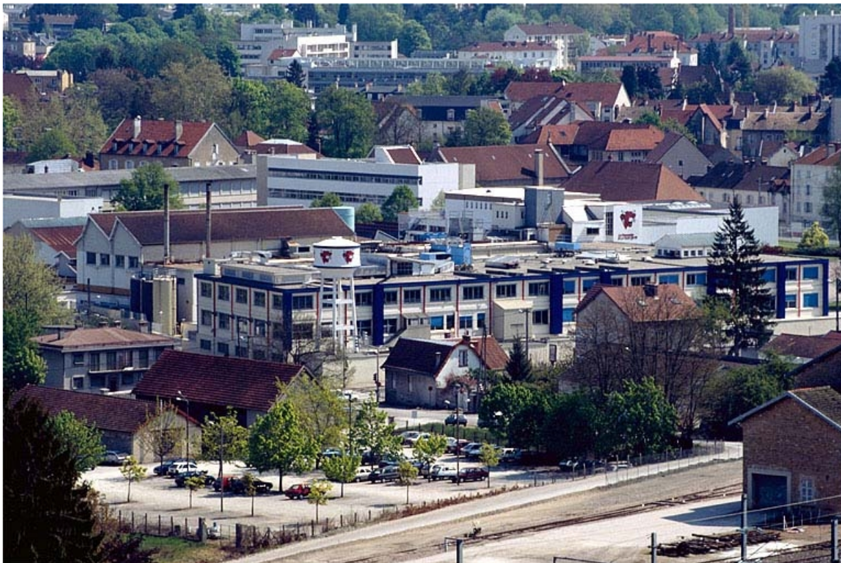
Vue d'ensemble depuis la côte de Montciel.
