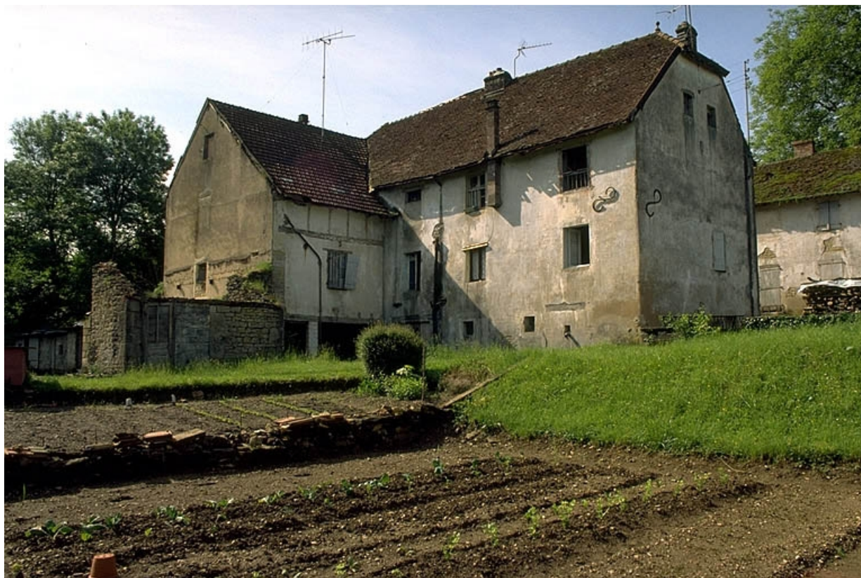
Bâtiment d'eau, atelier de fabrication et logement depuis le nord.
