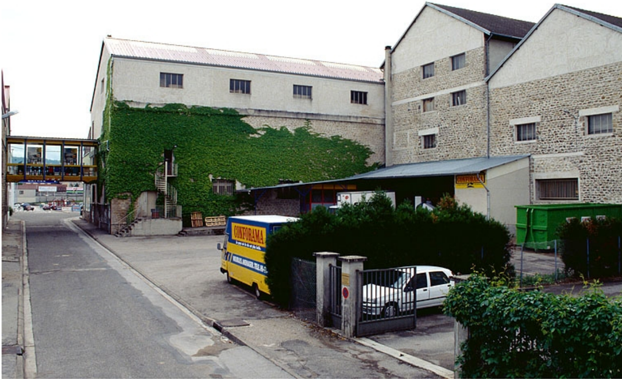
Atelier de fabrication depuis le nord-ouest.
