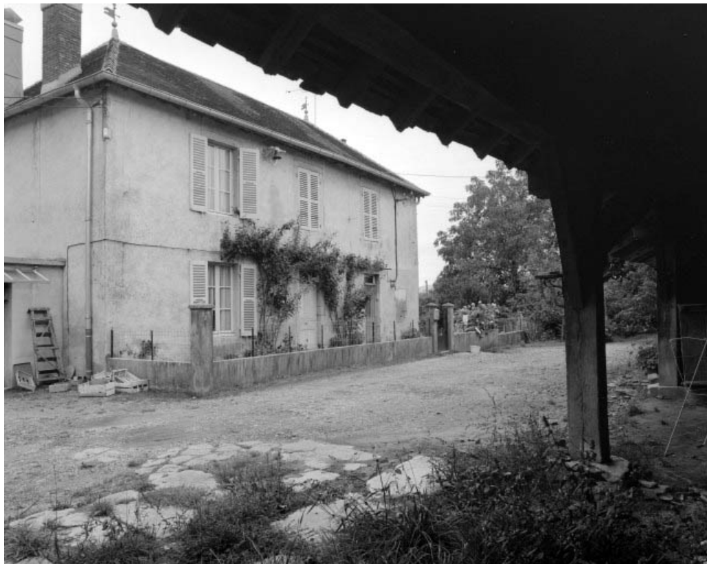
Logement patronal de trois quarts gauche.
