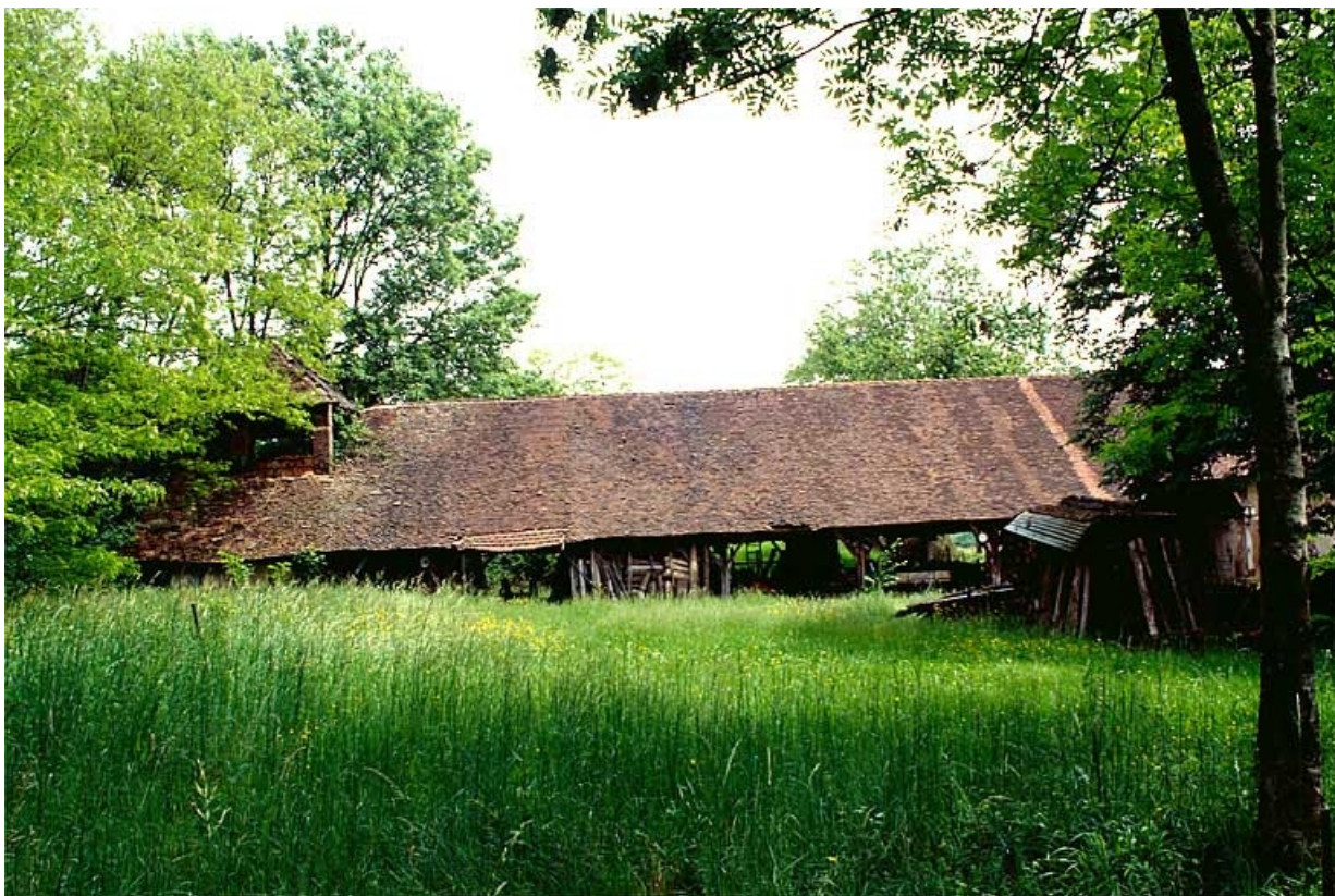
Bâtiment du four industriel et de la pièce de séchage.
