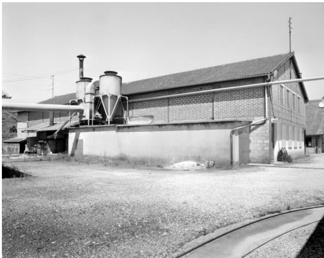
Atelier de fabrication, atelier de conditionnement, bureau.
