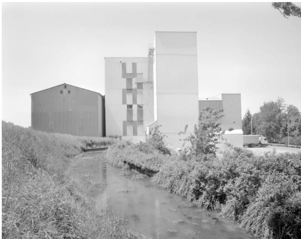
Silo et atelier de fabrication depuis l'est.
