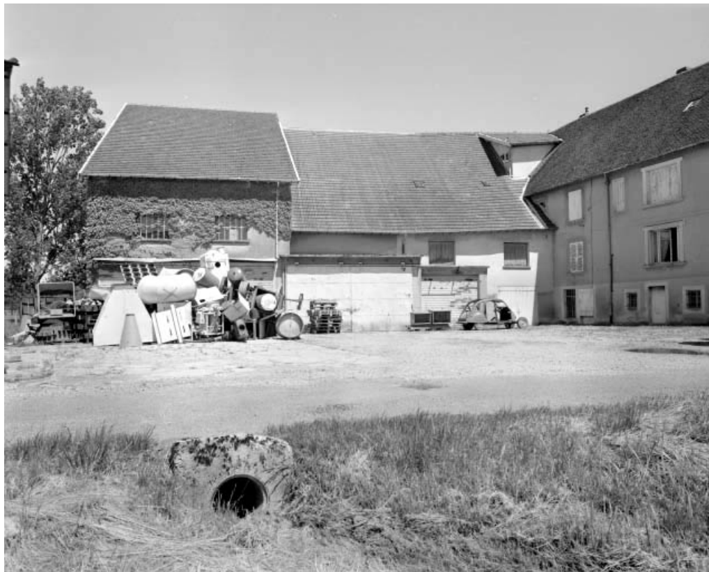
Façade postérieure de l'entrepôt industriel et de l'atelier de fabrication.
