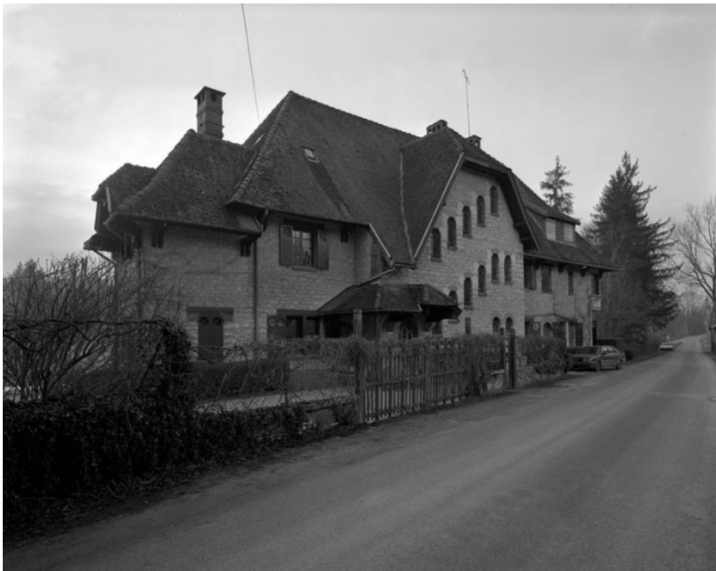
Façade antérieure du logement patronal de trois quarts gauche. 39, Patornay route de Barésia
