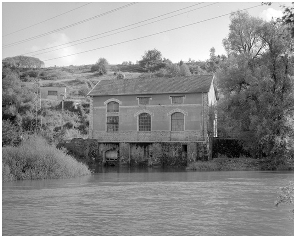
Façade postérieure de la centrale.
