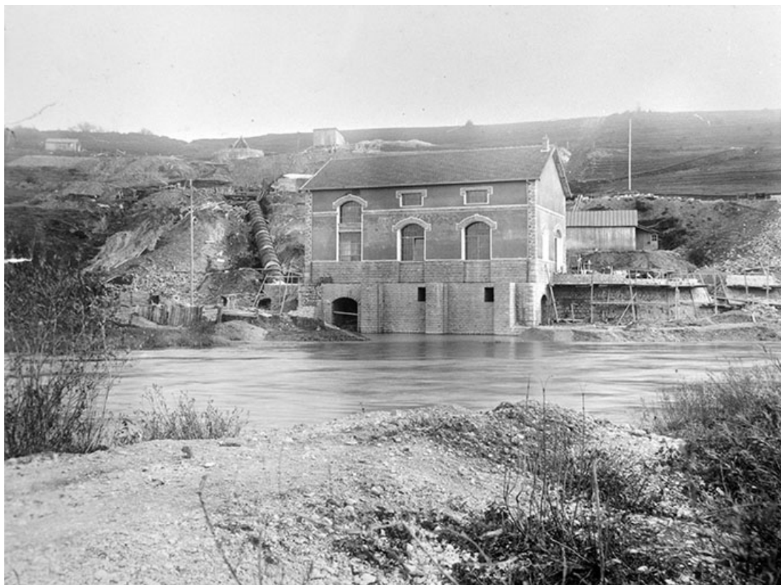
Centrale et conduite forcée en cours d'achèvement.
