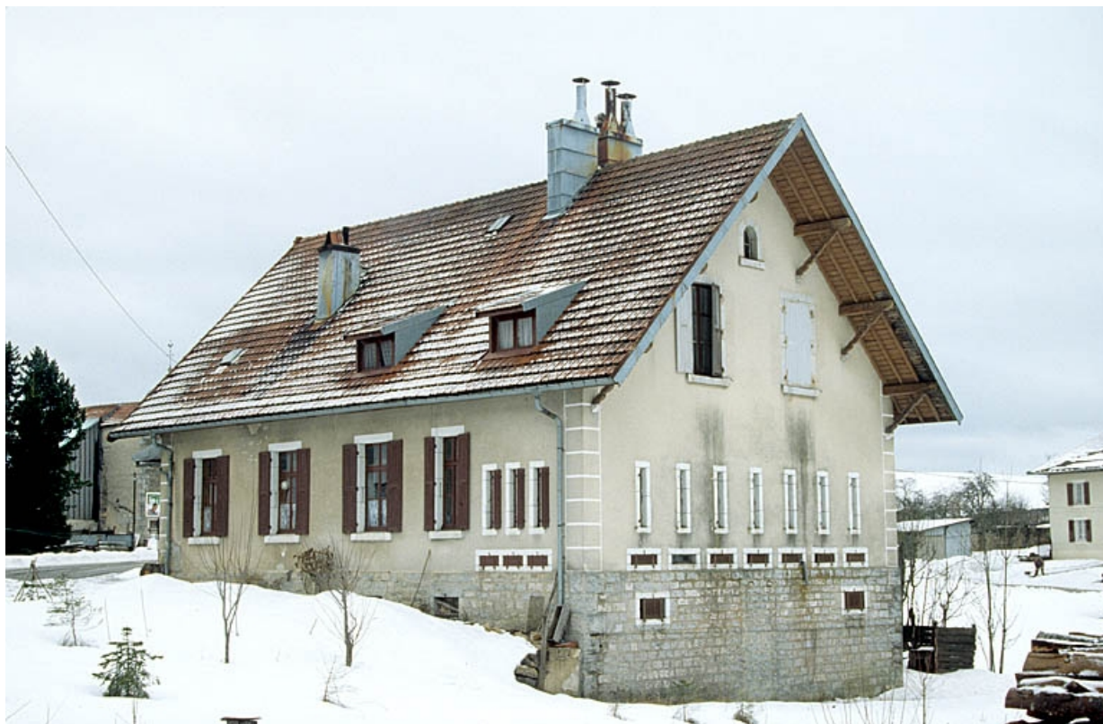
Façades postérieure et latérale droite.
