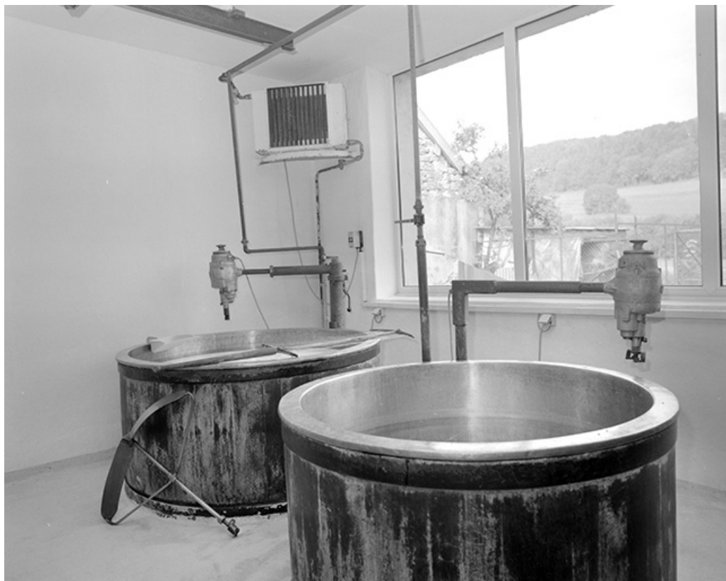
Chaudières, avec brasseur mécanique et tranche-caillé manuel. 39, Arthenas
