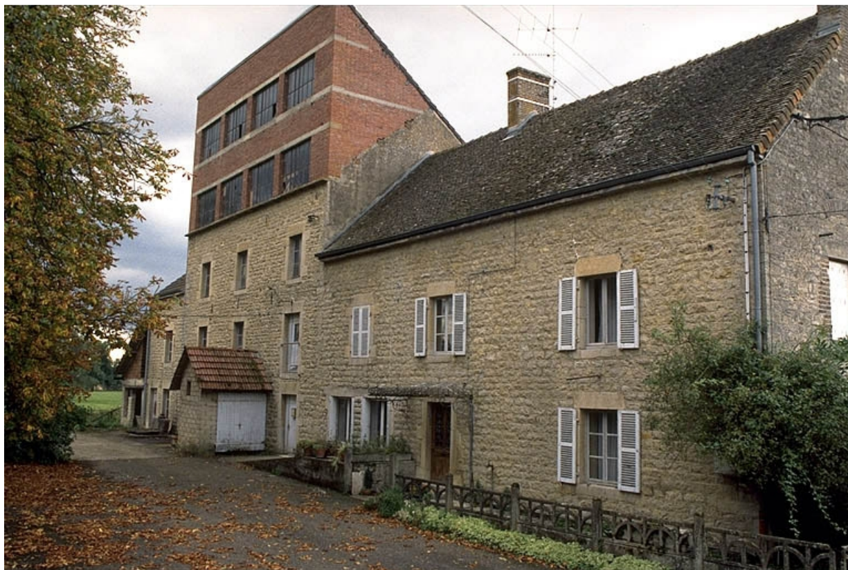
Façade antérieure depuis le nord-est. Atelier de fabrication réhaussé et logement. 39, Cosges rue des Prés Martin
