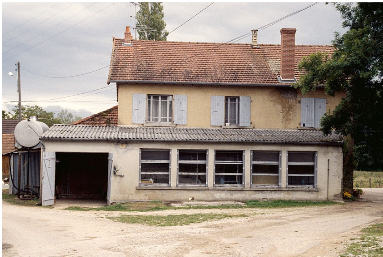
Façade latérale depuis le nord.
