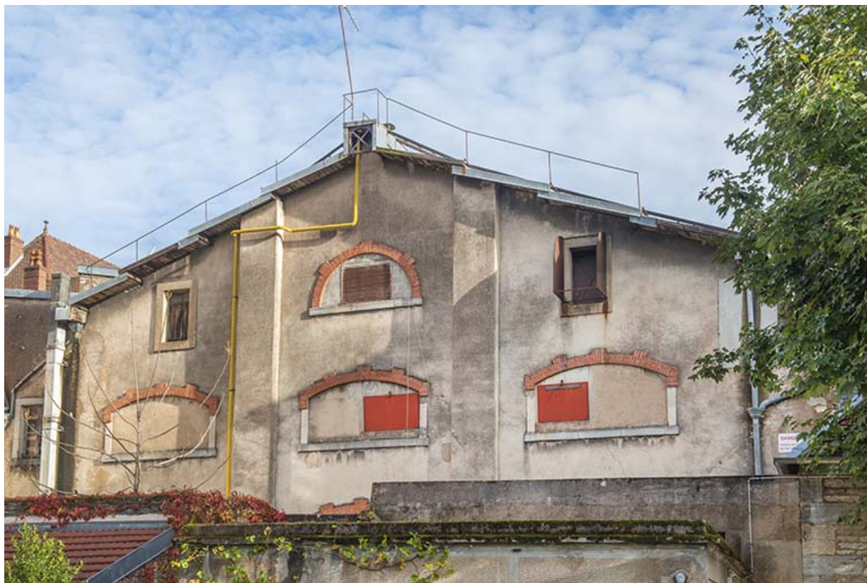
Façade postérieure de la halle (partie haute). 25, Besançon, 60-62 Grande Rue
