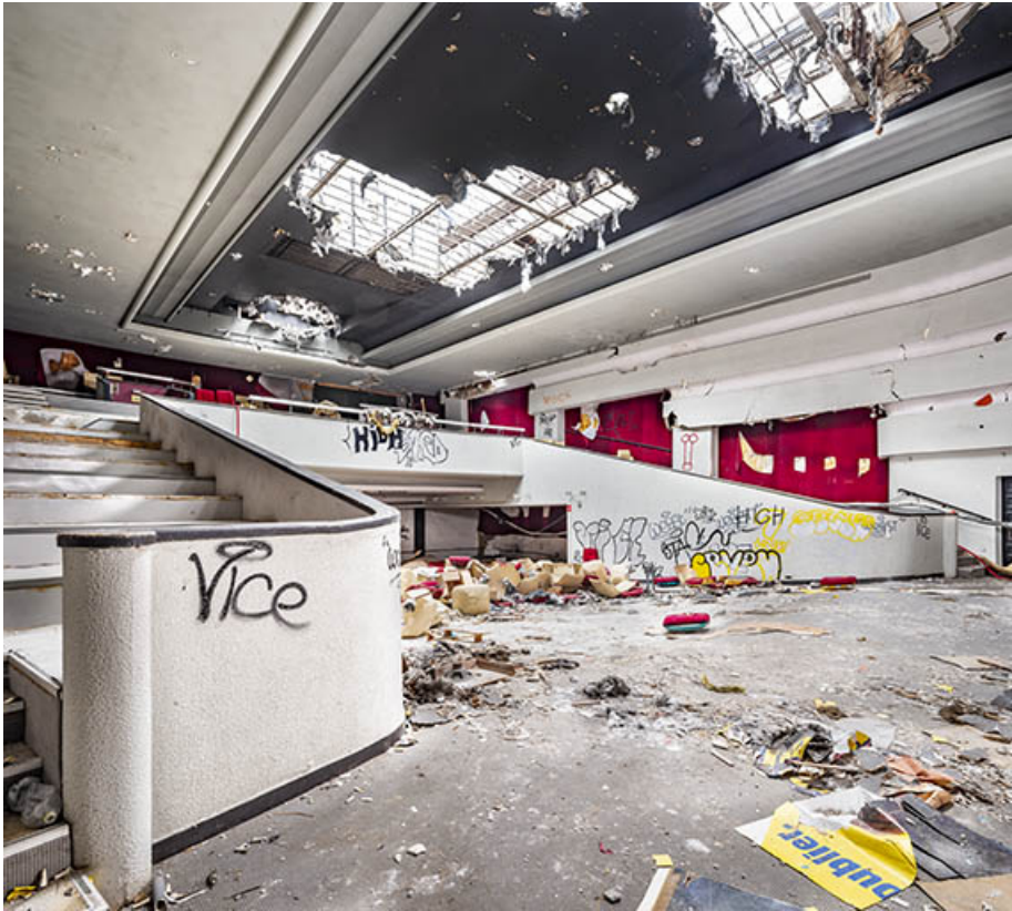
Halle : grande salle, le balcon vu de trois quarts gauche. 25, Besançon, 60-62 Grande Rue
