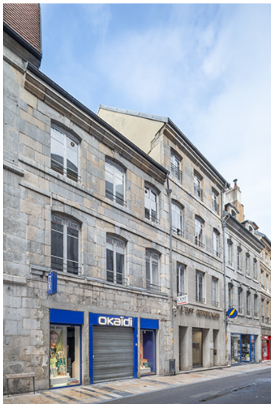
Vue d'ensemble des façades des n° 62 à 58 Grande Rue, de trois quarts gauche. 25, Besançon, 60-62 Grande Rue
