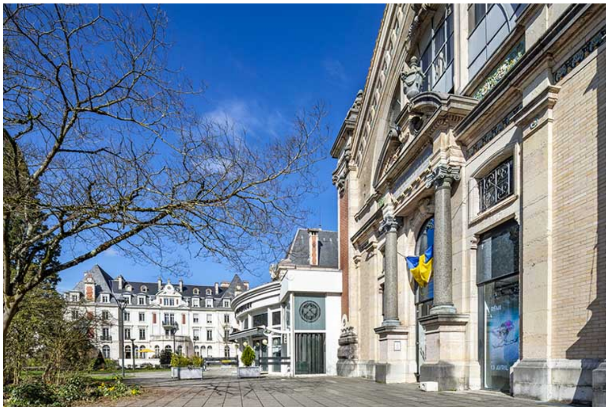
Façade principale, partie inférieure vue de trois quarts.
