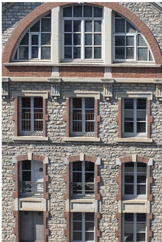
Façade sur la rue de la Mouillère, trois travées centrales.
