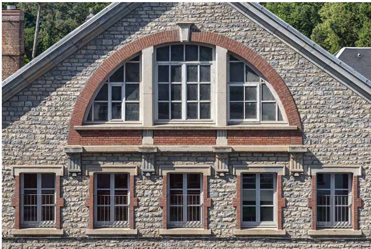
Façade sur la rue de la Mouillère, fenêtre thermique.
