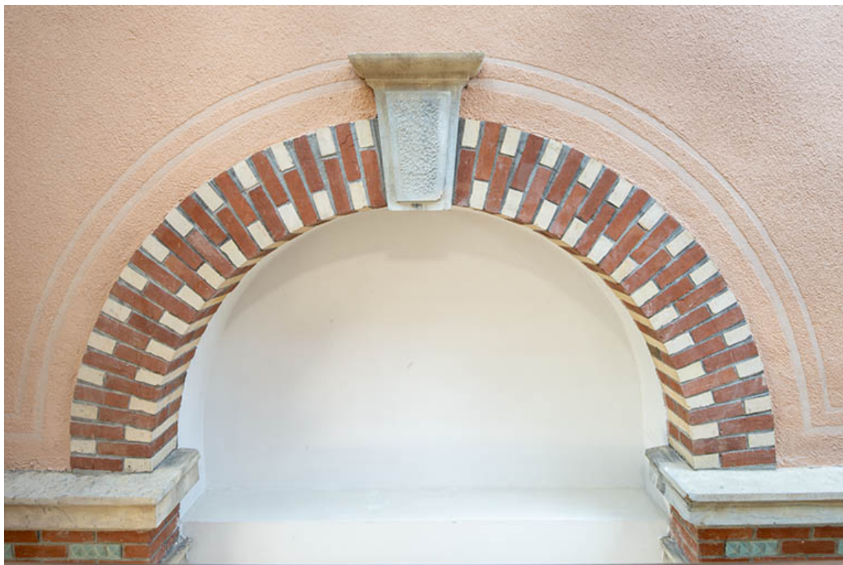
Façade latérale, aujourd'hui donnant dans l'extension de 1993, détail.
