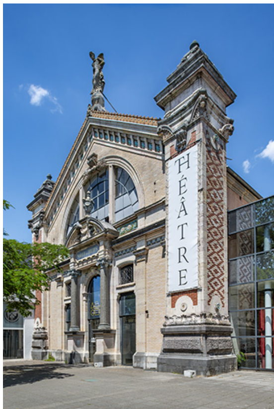
Façade principale, vue de trois quarts.
