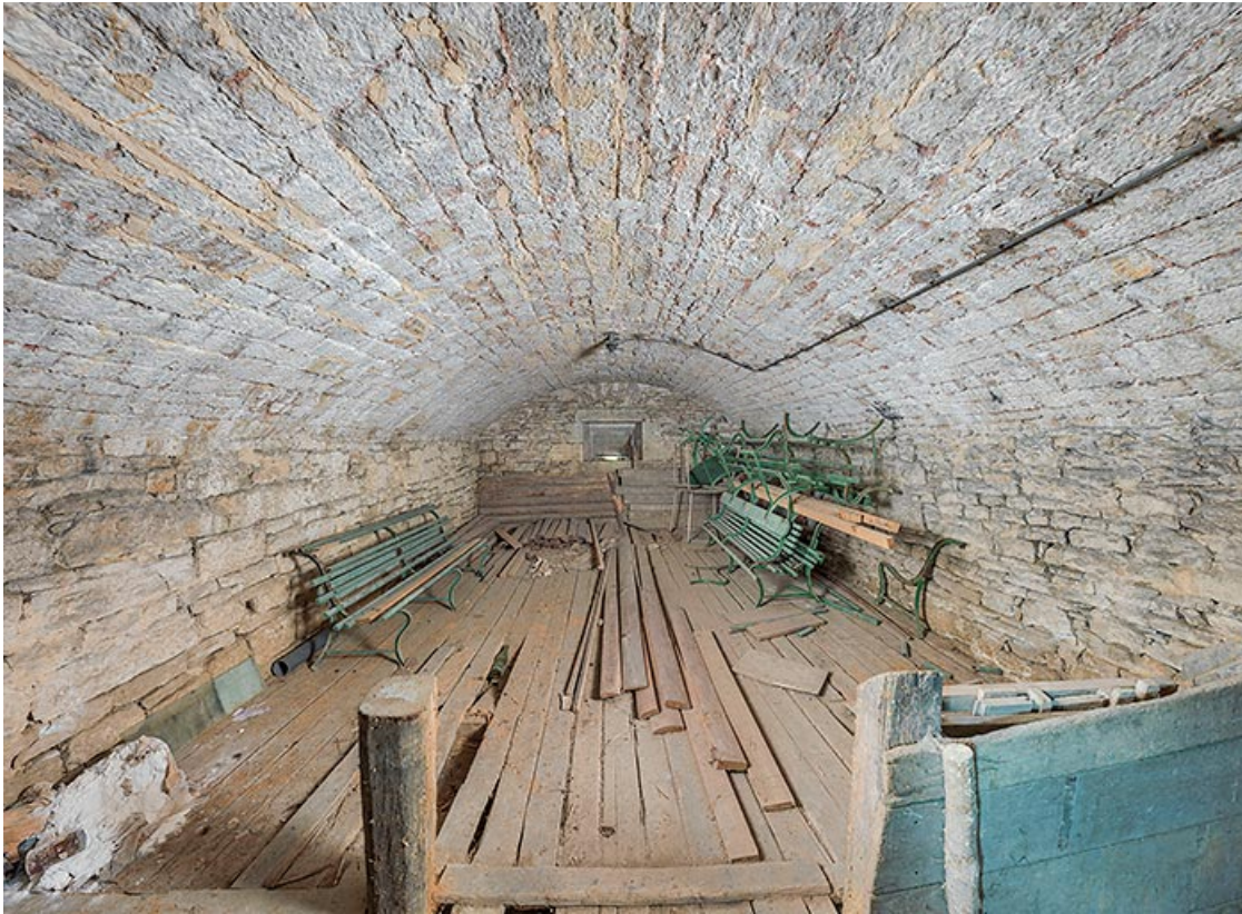
Casemate et sa voûte à l'épreuve.
