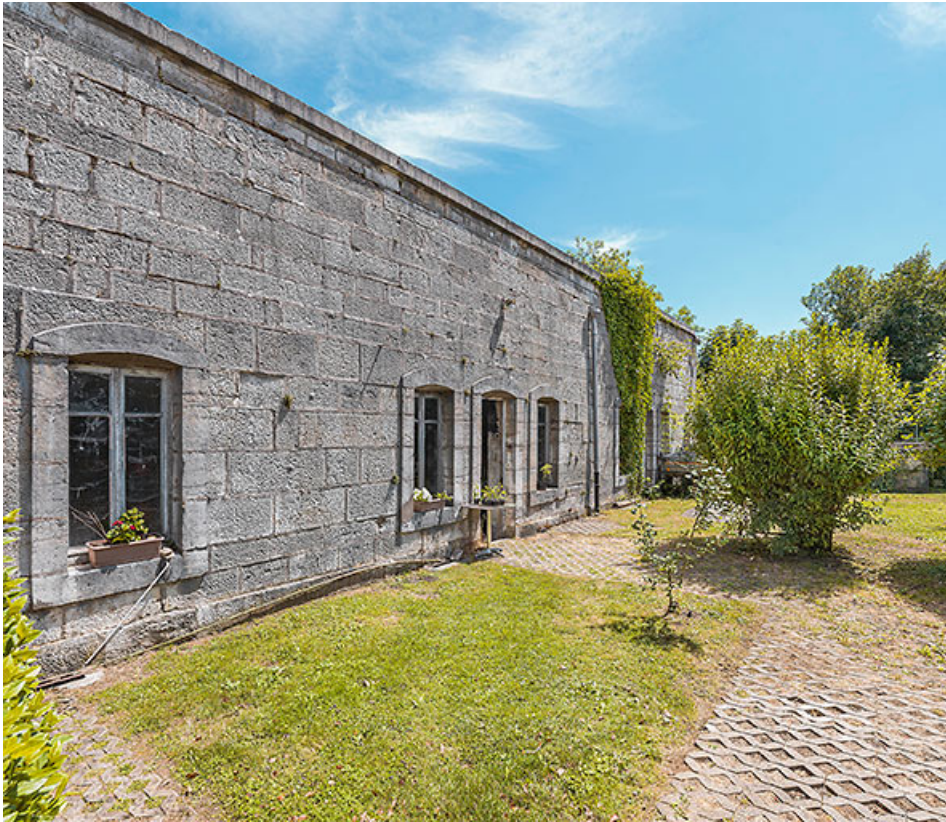
Les casemates conservées et transformées en locaux techniques. 25, Blamont rue Viette
