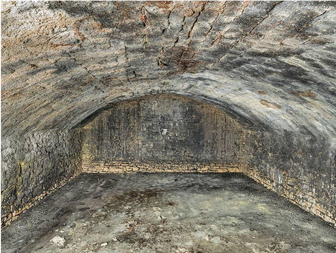
Autre casemate du niveau inférieur.
