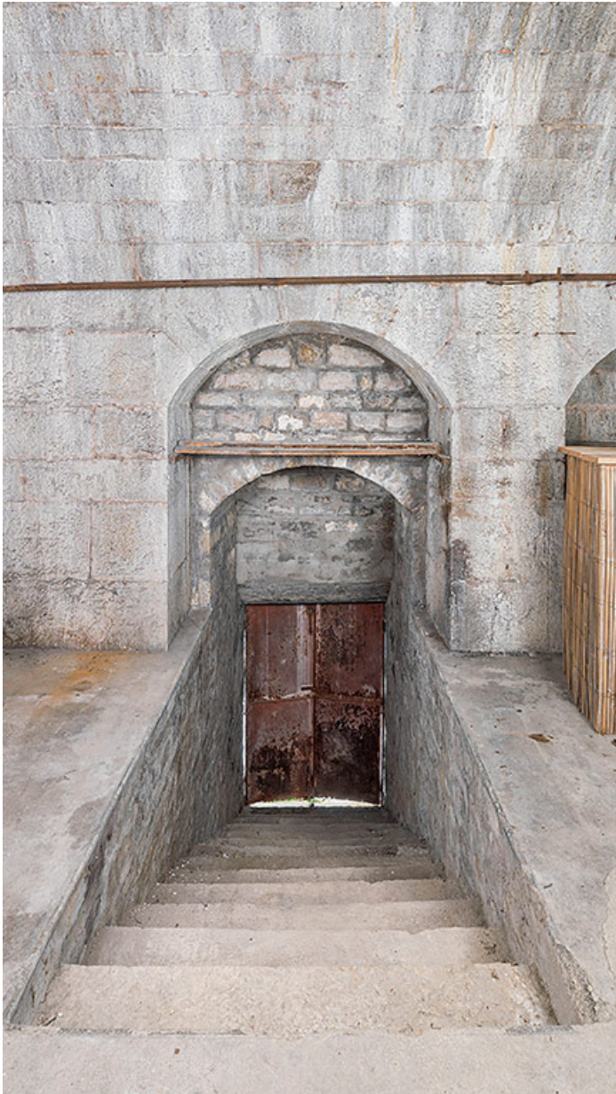
Escalier intérieur vers la poterne dans la casemate.
