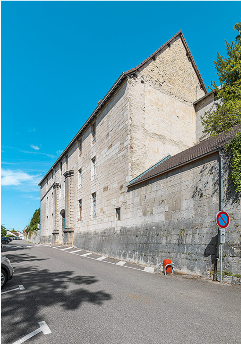
Le pavillon, vue orientale de trois quarts. 25, Blamont rue Viette
