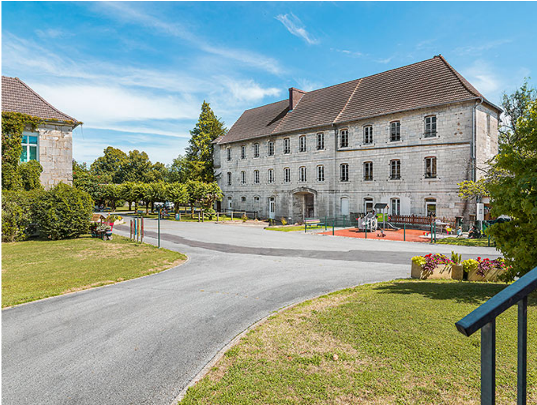
Le pavillon, vue de trois quarts depuis la cour intérieure. 25, Blamont rue Viette
