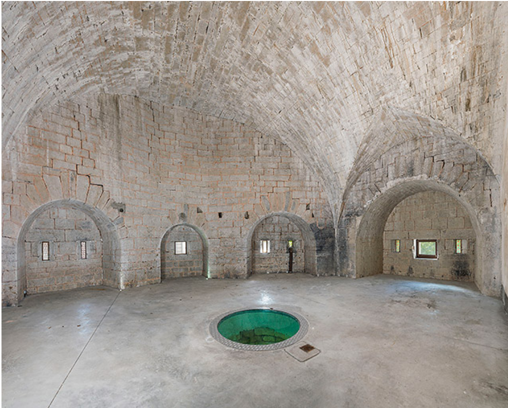
Le bastion du puits, vue générale intérieure. Le puits est au centre. 25, Blamont rue Viette
