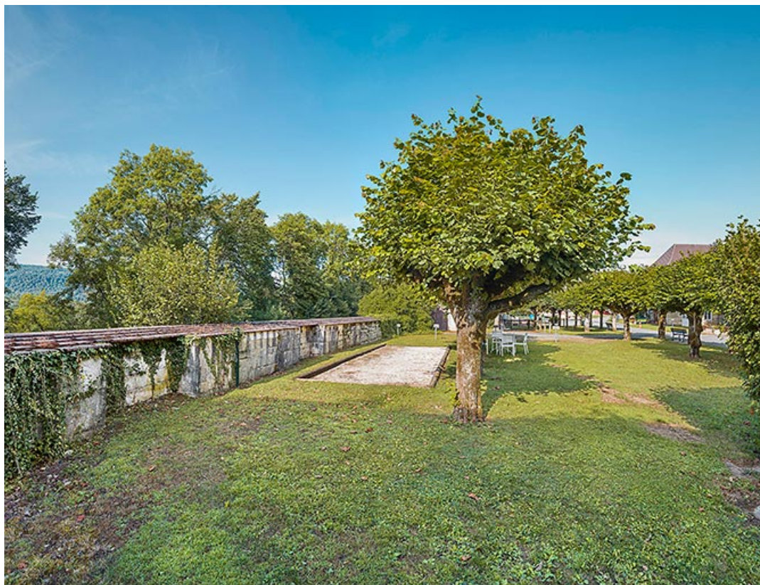
La courtine sud, vue depuis la cour intérieure.
