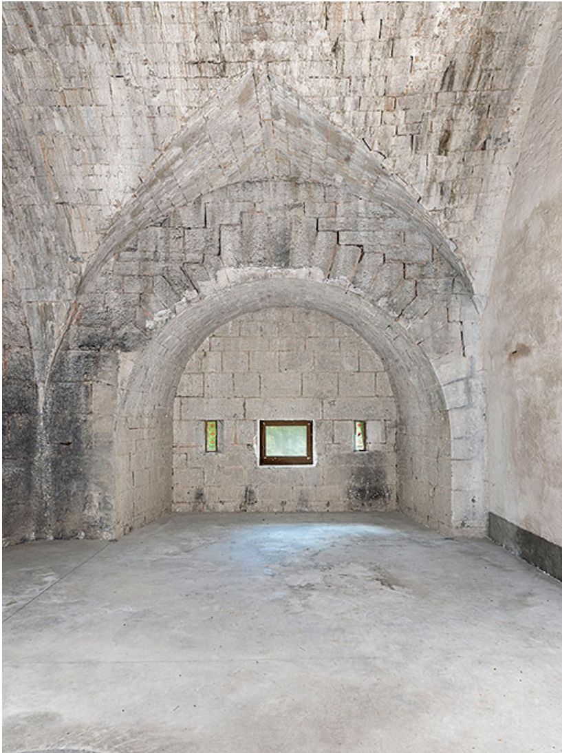
Bastion du puits : "alcove" avec embrasures du flanc sud. 25, Blamont rue Viette
