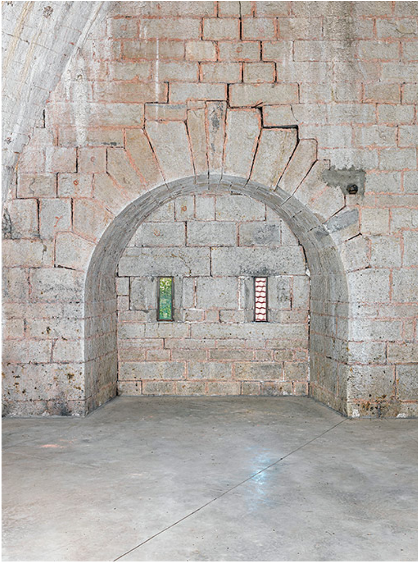
Bastion du puits : "alcove" avec embrasures de la face nord. 25, Blamont rue Viette
