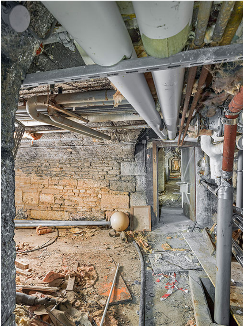
La galerie desservant les casemates du front bastionné, niveau inférieur. 25, Blamont rue Viette
