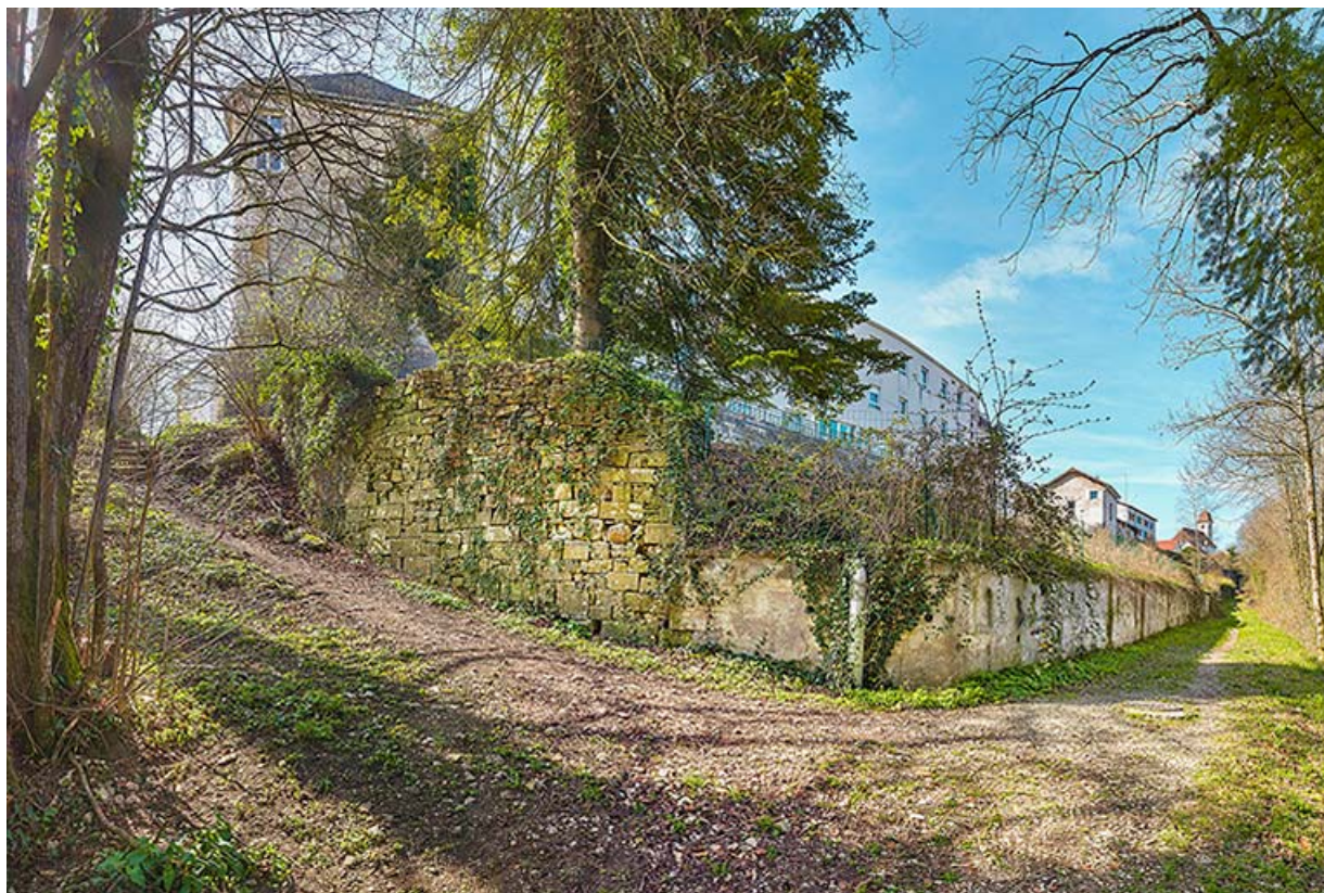
Mur d'enceinte dans le prolongement du front.
