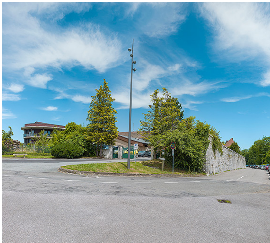
Entrée actuelle de la maison de retraite. Sur la droite, la courtine sud est encore présente. 25, Blamont rue Viette
