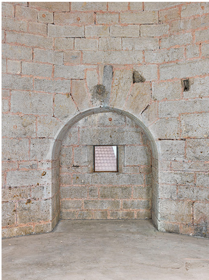
Bastion du puits : "alcove" avec embrasure du flanc nord. 25, Blamont rue Viette
