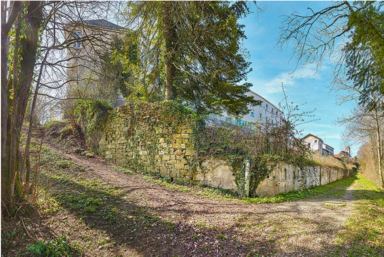
Mur d'enceinte dans le prolongement du front.
