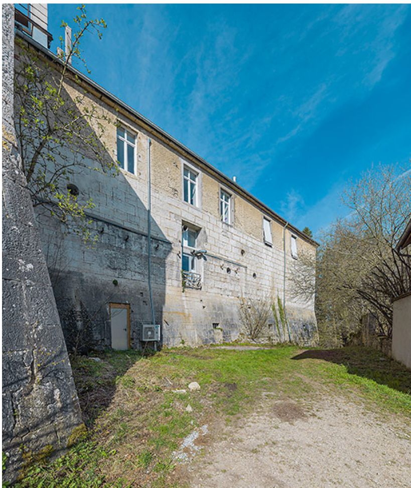
La partie nord du front bastionné (comprenant la poterne d'accès aux casemates). 25, Blamont rue Viette
