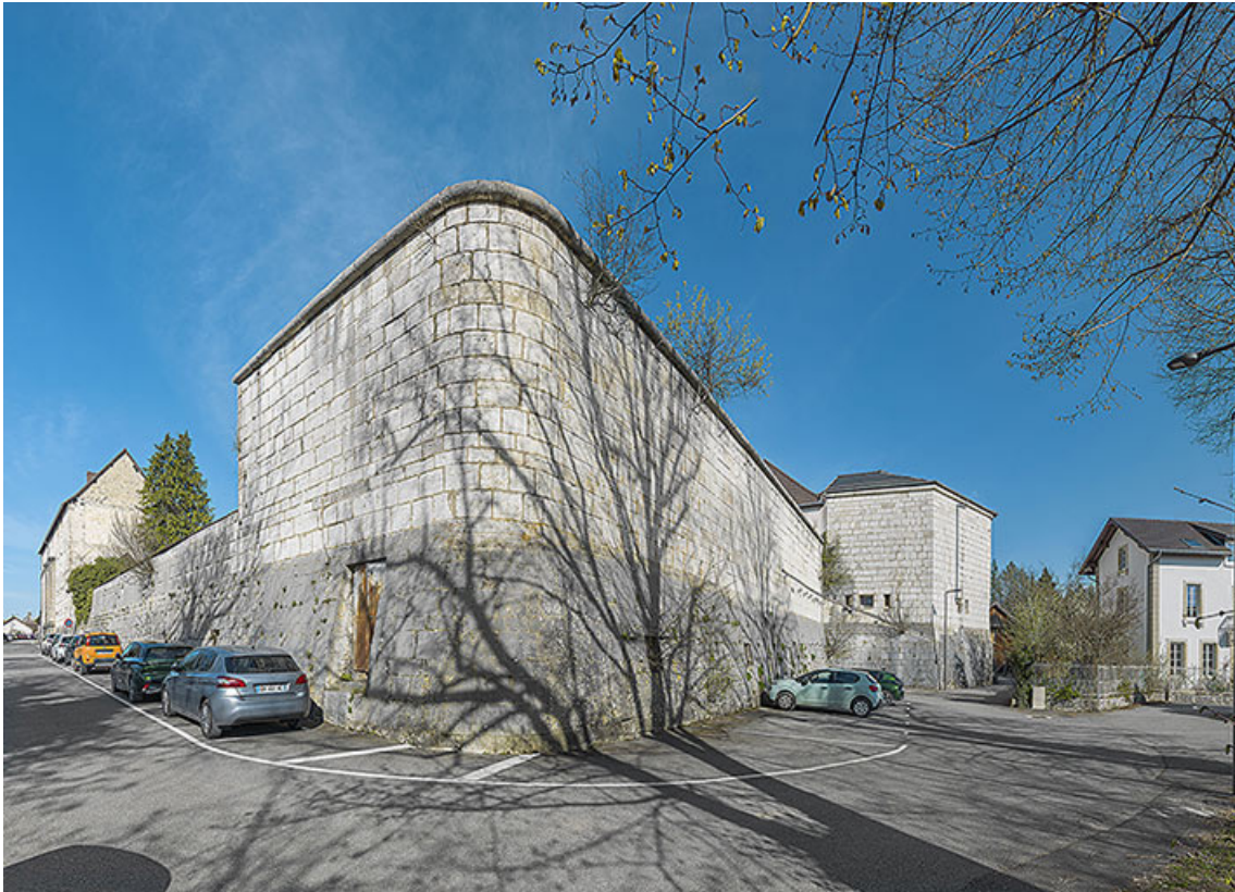
Le front bastionné, vue de trois quarts gauche. 25, Blamont rue Viette
