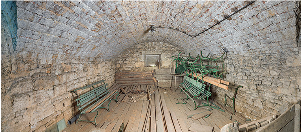
Vue générale d'une casemate.
