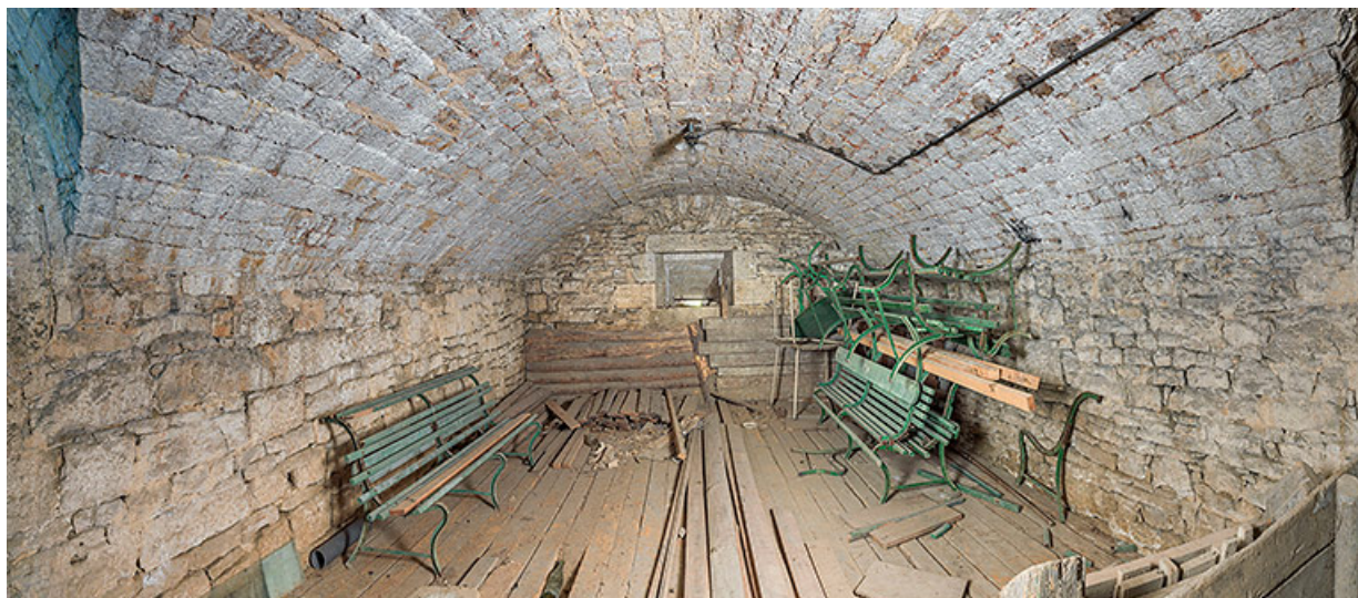
Vue générale d'une casemate.
