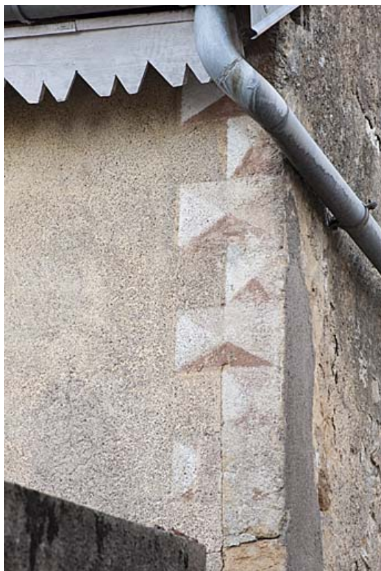
Décor en "pointe de diamant" peint en façade de la maison au 11 rue des Gratteris (2010 AK 48) : détail. 25, Rougemont
