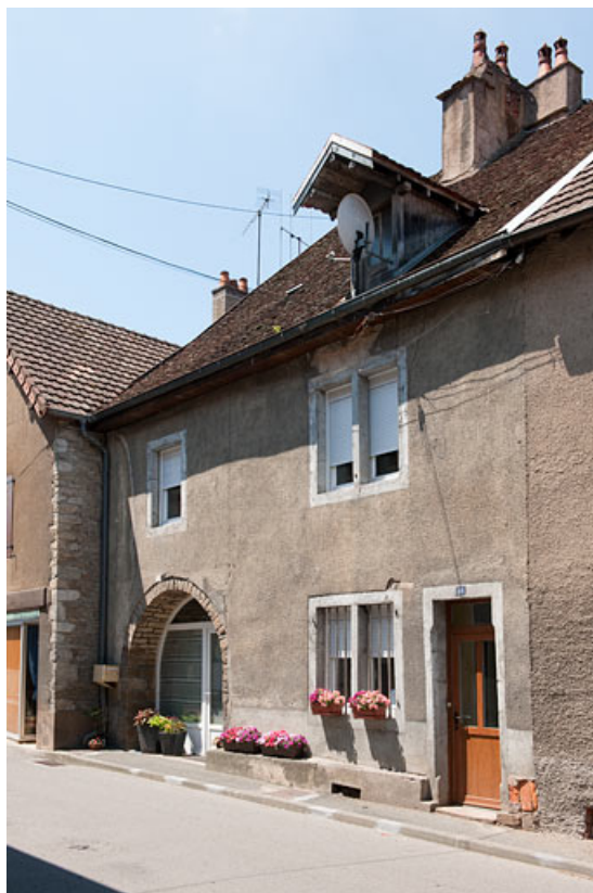
Ferme au 10 Grande Rue (2010 AL 46) : façade antérieure. 25, Rougemont
