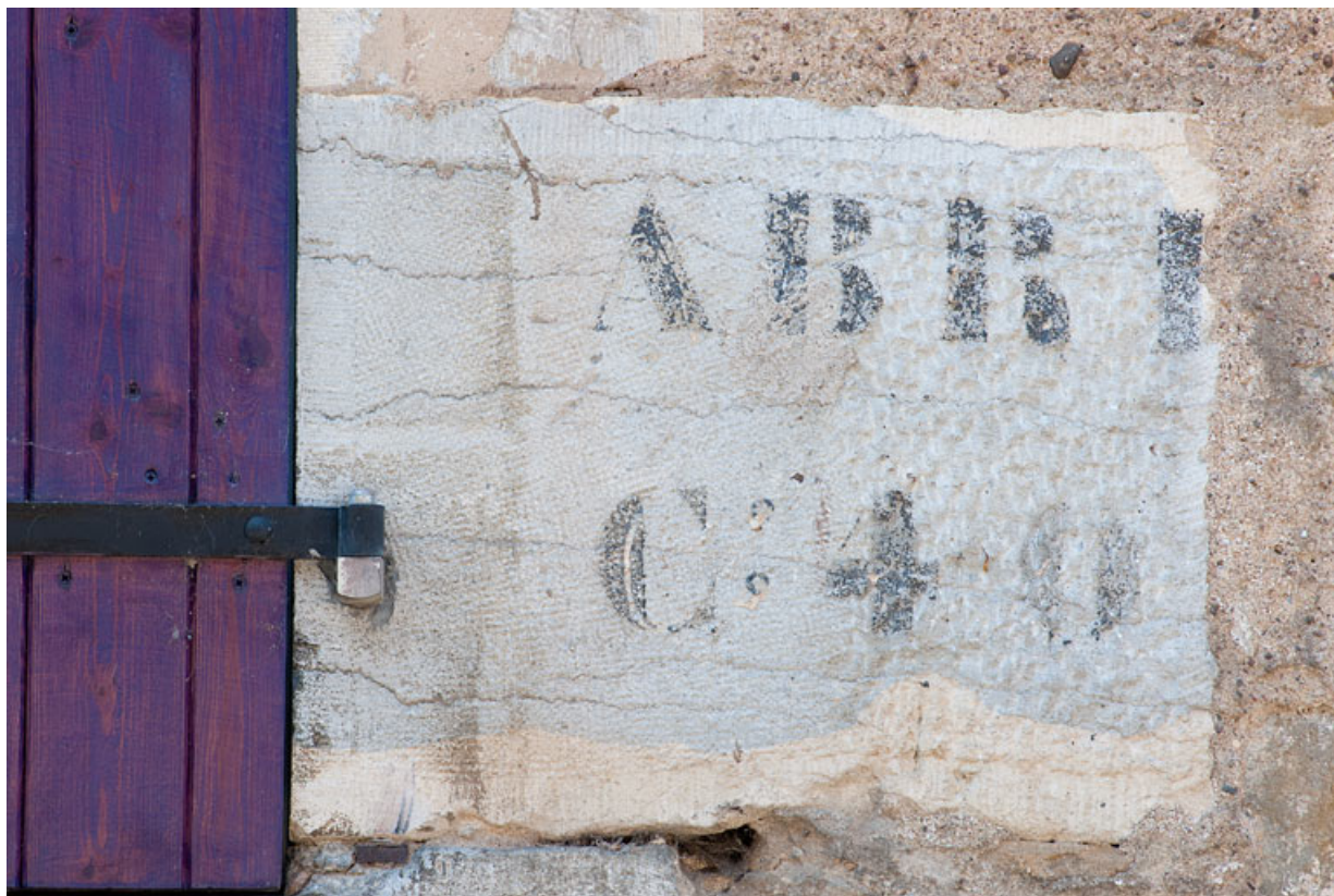
Maison au 14 rue des Gratteris (2010 AK 111) : inscription sur le piédroit de la fenêtre. 25, Rougemont
