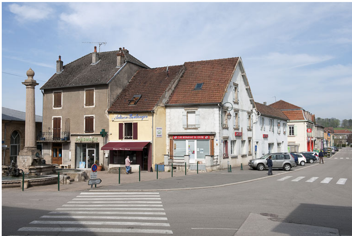
Avenue de la Gare : extrémité proche de la mairie. 25, Rougemont
