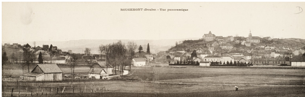
Rougemont (Doubs) - Vue panoramique. S.d. [1ère moitié 20e siècle] 25, Rougemont
