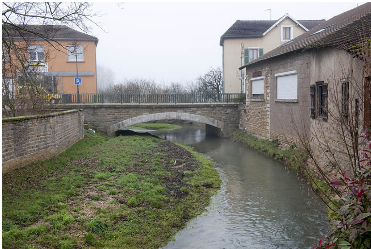
Pont sur le Drigeon, avenue de la Gare. 25, Rougemont
