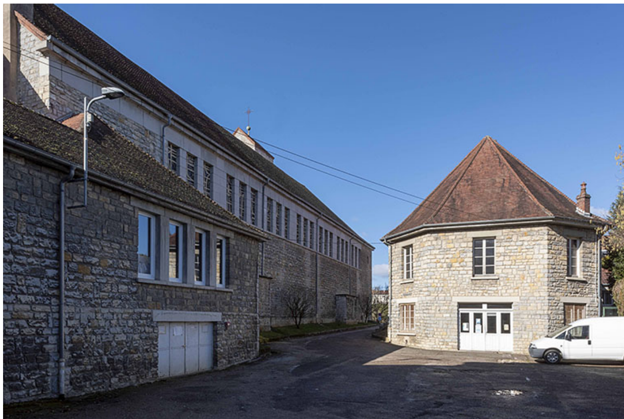
De gauche à droite : sacristie, église et maison des œuvres - cinéma Villarceau. 25, Besançon, 18 avenue Villarceau
