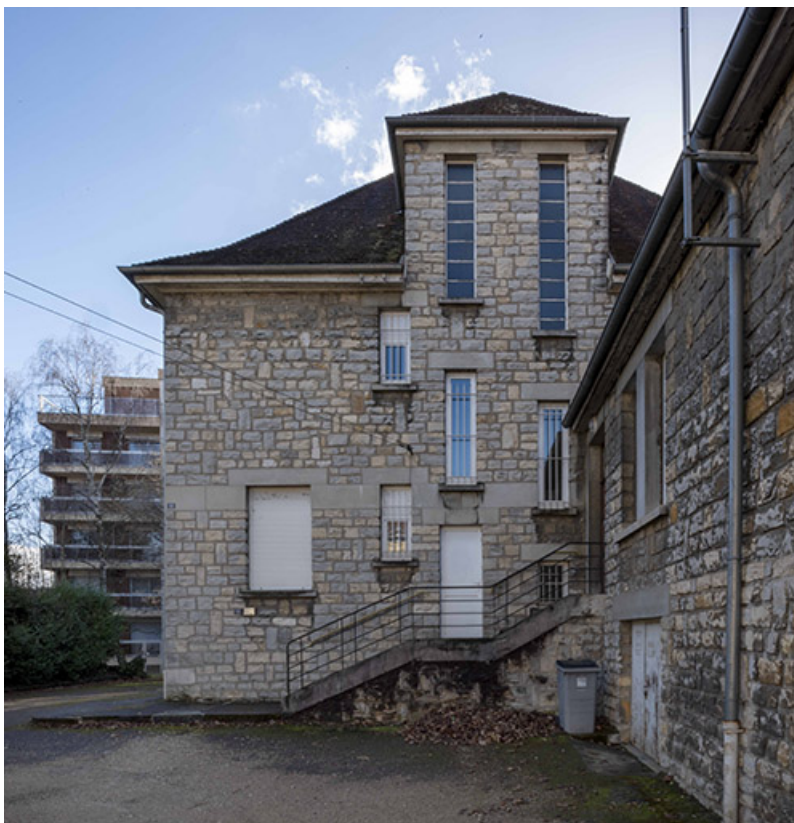
Façade nord du presbytère et bâtiment abritant la chapelle, la sacristie et la chaufferie de l'église. 25, Besançon, 18 avenue Villarceau
