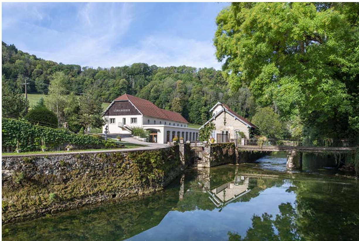
Rives du Cusancin, vue en direction de l'écurie-remise. 25, Guillon-les-Bains
