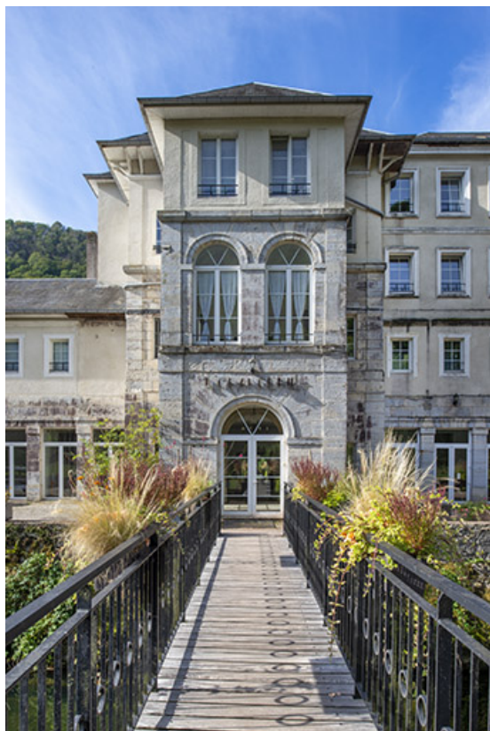
Façade principale, vue de face, détail : avant-corps central. 25, Guillon-les-Bains route départementale 21, lieudit : les Bains
