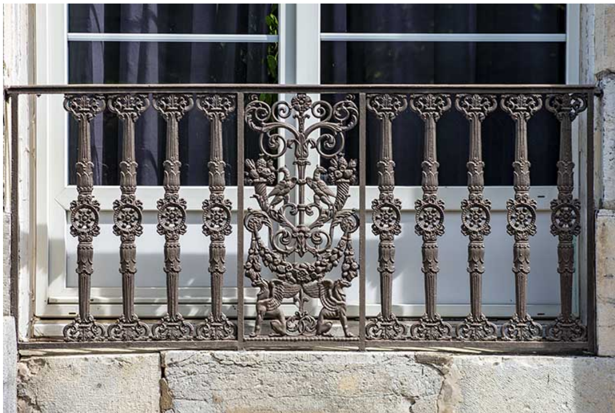
Façade arrière, vue de face, détail : garde-corps d'une baie de l'avant-corps central.
