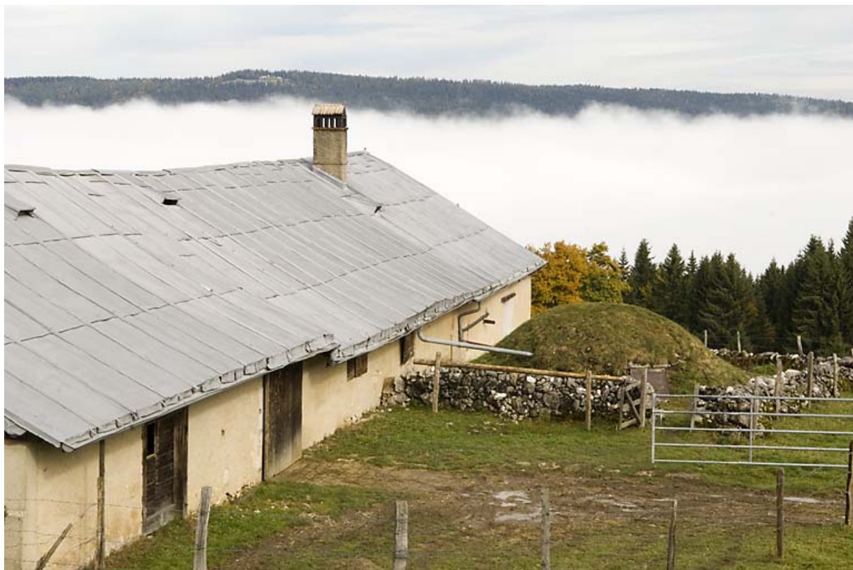
Façade antérieure vue en enfilade et citerne.
